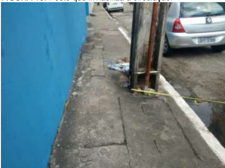
FIGURA 19: Poste que inviabiliza a circulação.
