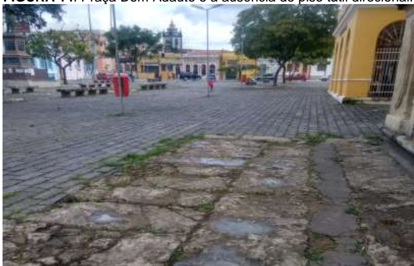
FIGURA 14: Praça Dom Adauto e a ausência de piso tátil direcional.
