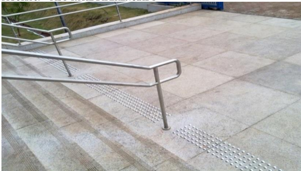
FIGURA 39 – PISO TÁTIL DIFERENCIADO
