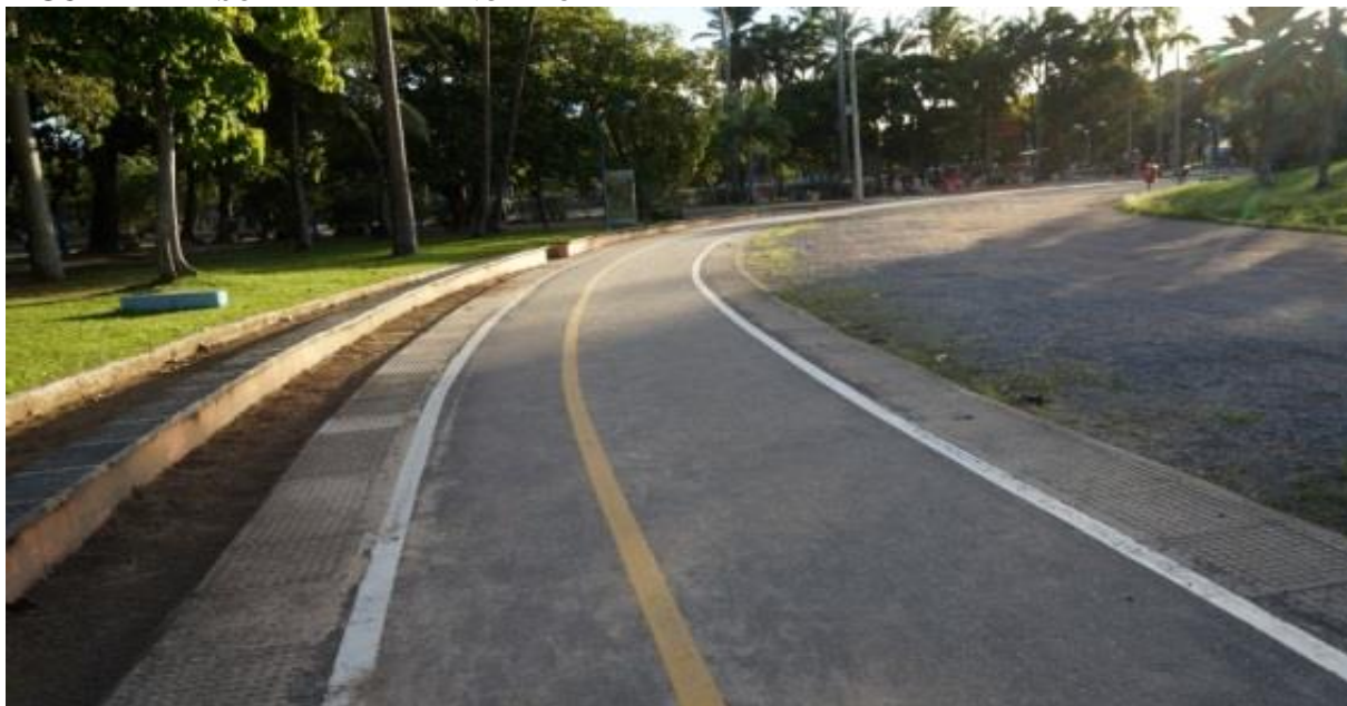
FIGURA 74 – PISO TÁTIL DIFERENCIADO
