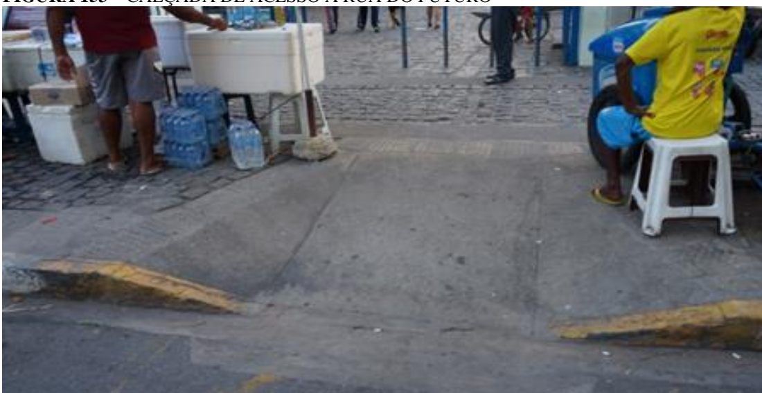
FIGURA 153 – CALÇADA DE ACESSO À RUA DO FUTURO
