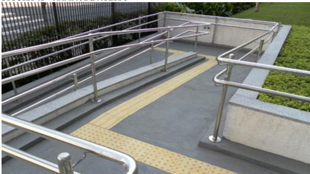
FIGURA 41 – RAMPA DE ACESSO
