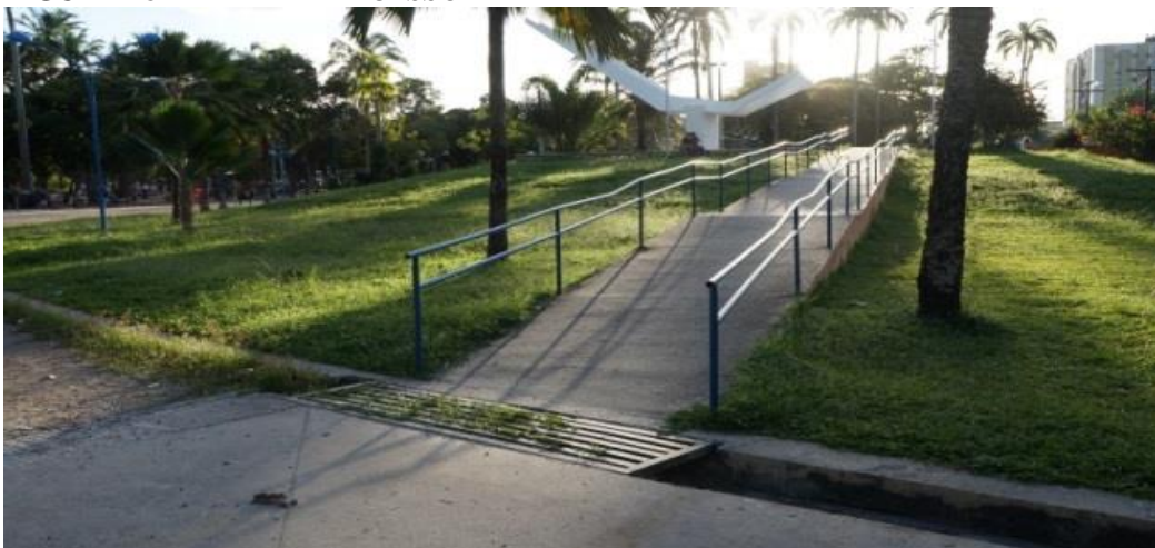
FIGURA 78 – RAMPA DE ACESSO
