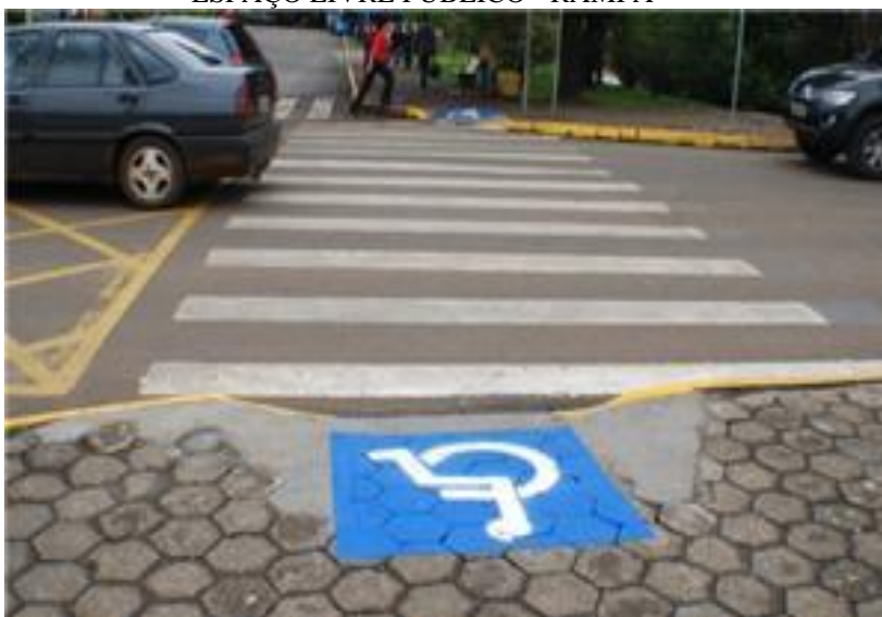
FIGURA 36 – CALÇADAS E RUAS DO ENTORNO DE UM ESPAÇO LIVRE PÚBLICO - RAMPA
