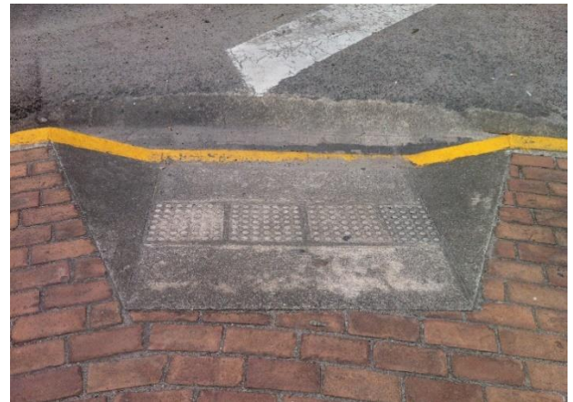
FIGURA 26: Piso tátil aplicado indevidamente. FONTE: Autora, 2015.
