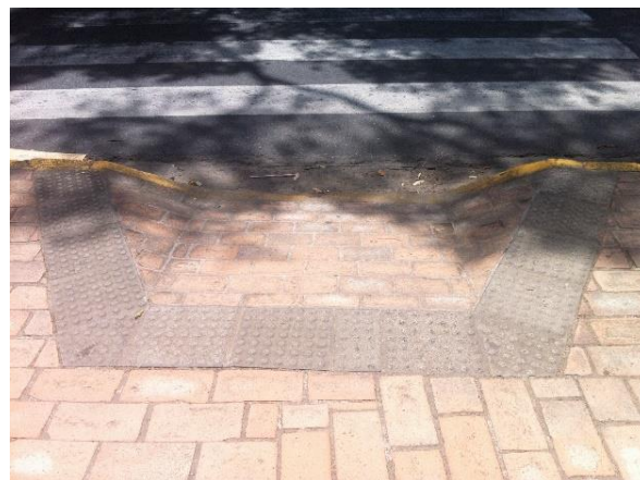
FIGURA 15: Rampa acessível com desnível para a via de carroceria. FONTE: Autora, 2015.
