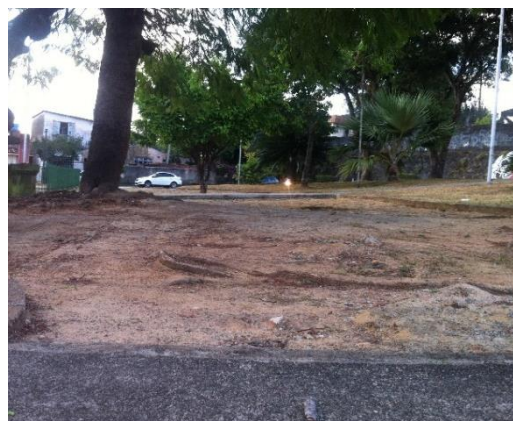
FIGURA 46: Piso em condições inadequadas. FONTE: Autora, 2015.
