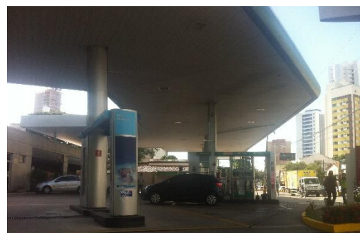
FIGURA 73: Posto de Combustível. FONTE: Autora, 2015.
