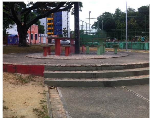
FIGURA 38: Acesso apenas através de escada.
