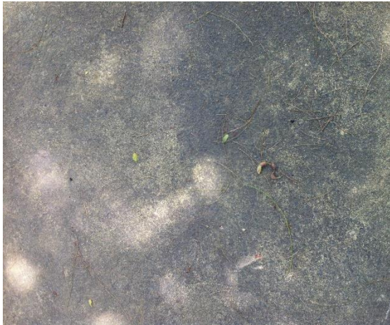
FIGURA 39: Piso em cimento. FONTE: Autora, 2015.
