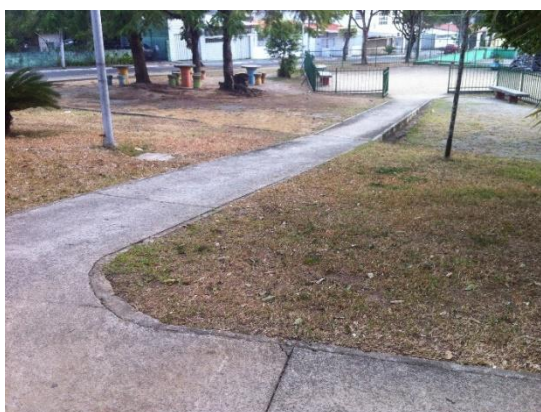
FIGURA 47: Rampas inclinadas sem corrimão. FONTE: Autora, 2015
