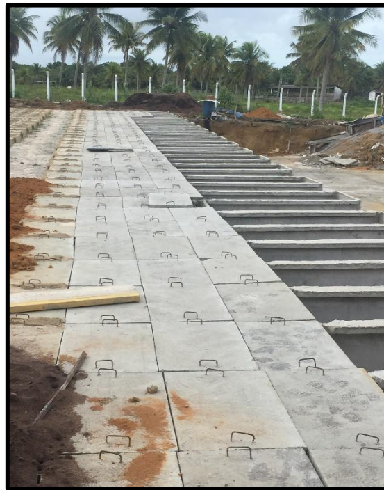
FIGURA 44: Jazigos em construção
