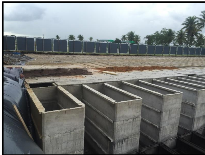
FIGURA 42: Jazigos em construção
