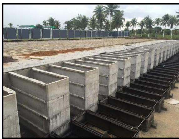
FIGURA 41: Jazigos em construção
