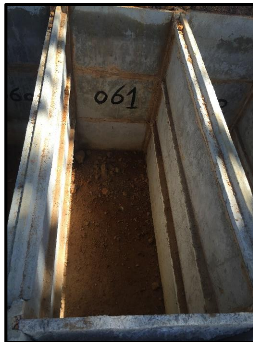
FIGURA 92: Jazigo em construção
