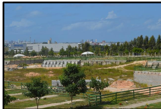
FIGURA 97: Jazigos em construção
