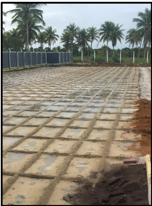
FIGURA 43: Jazigos em construção
