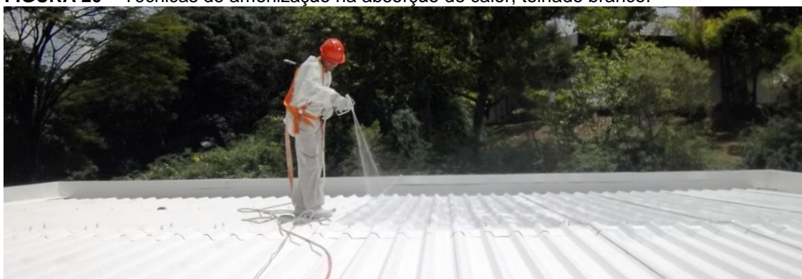
FIGURA 20 – Técnicas de amenização na absorção de calor, telhado branco.
