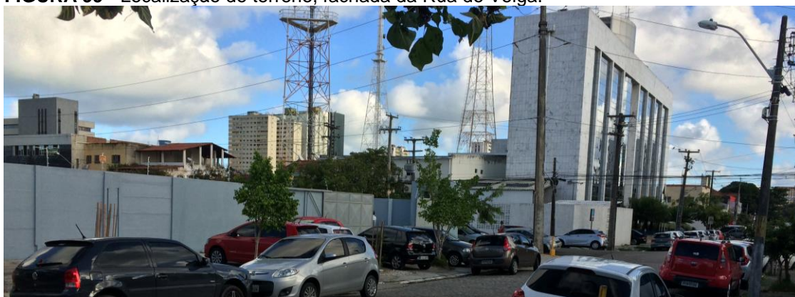
FIGURA 99 - Localização do terreno, fachada da Rua do Veiga.
