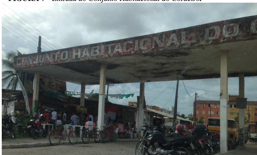
FIGURA 7 - Entrada do Conjunto Habitacional do Cordeiro.
