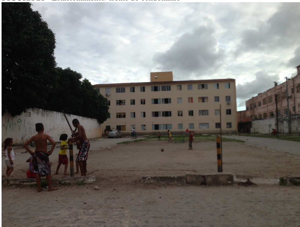
FIGURA 28 - Estacionamento/ frente do condomínio
