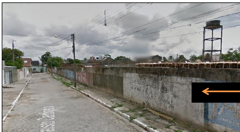
FIGURA 114 - Vista dos fundos do terreno na Rua Fausto Cardoso.
