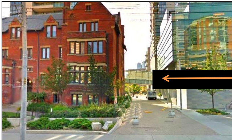
FIGURA 88 - Ligação entre os dois prédios
