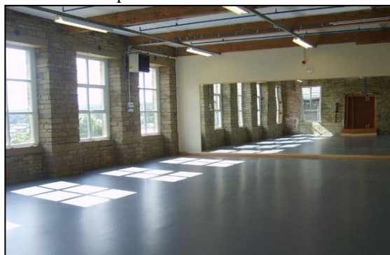
FIGURA 19 - Piso flutuante em madeira com o linóleo na cor preta.
