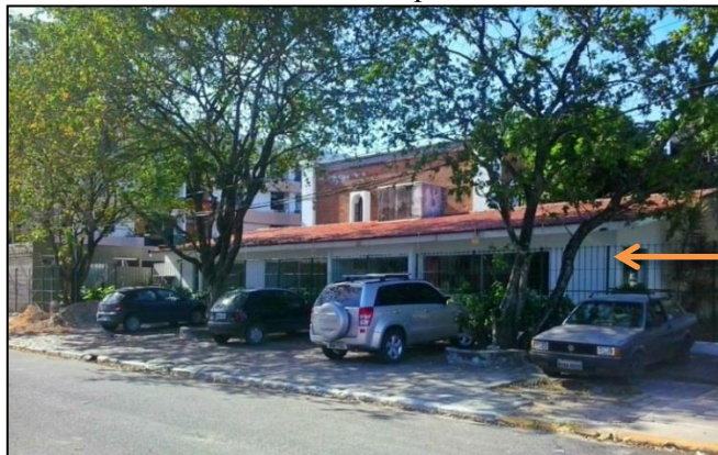
FIGURA 65 - Estacionamento na parte externa.
