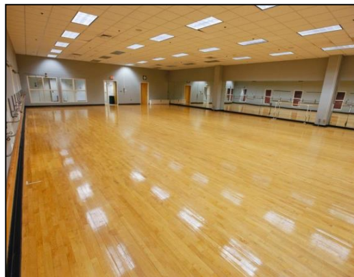
FIGURA 17 - Piso flutuante de madeira.
