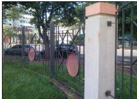
FIGURA 89: Detalhe do Gradil
