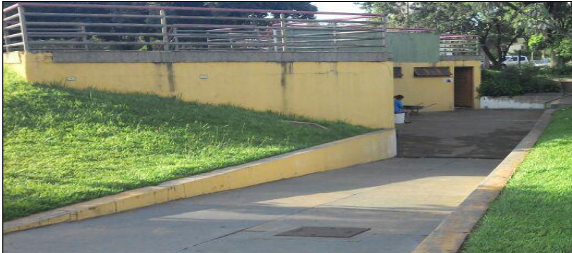
FIGURA 94: Duchas e banheiros
