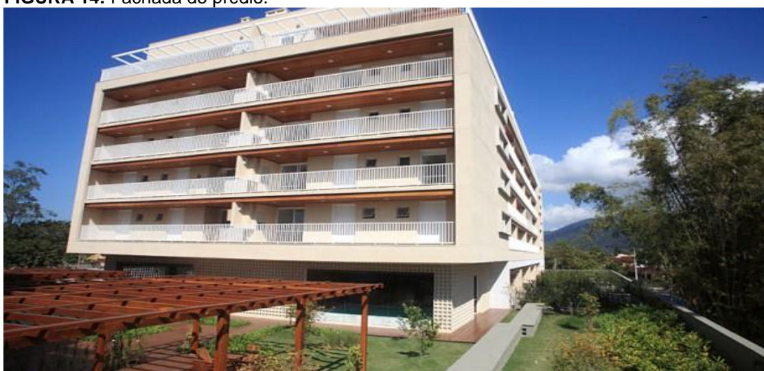
FIGURA 14: Fachada do prédio.
