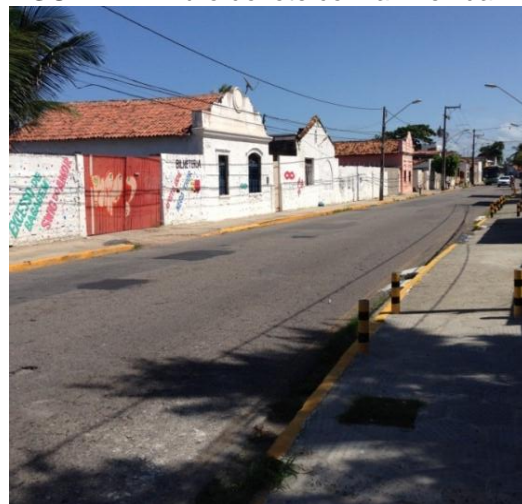
FIGURA 47: Muro do lote com a Avenida.
