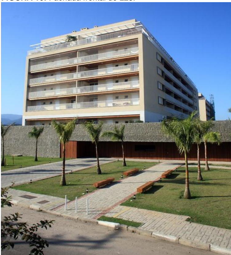
FIGURA 10: Fachada frontal do L23.
