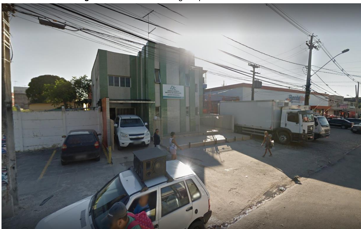
Figura 15 - Fachada do Abrigo Espírita Batista de Carvalho
