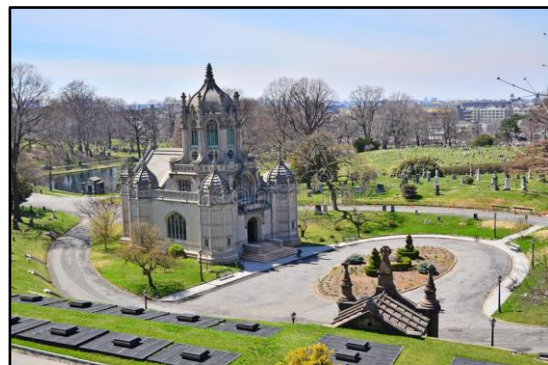
Figura 27 – Vista da capela central
