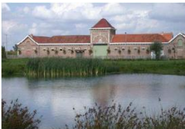
Figura 49: Fachada da Ferme du Mont Saint-Jean, em Halluin, na França. Fonte: Brum, 2010, p. 119.
