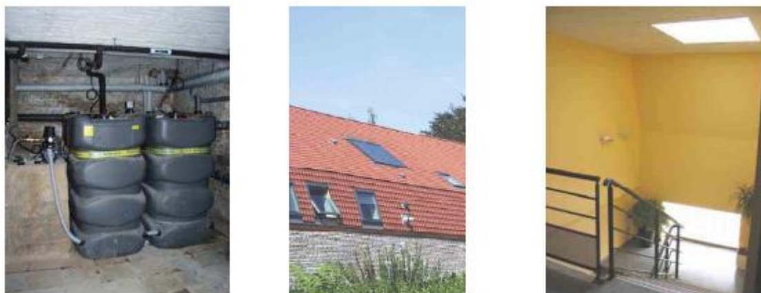
Figura 48: Intervenções no Maison des Sauvers, em Saint-André Lez Lille, na França, respectivamente, implantação de cisternas para coleta de água da chuva, painéis solares e aporte de iluminação natural.
