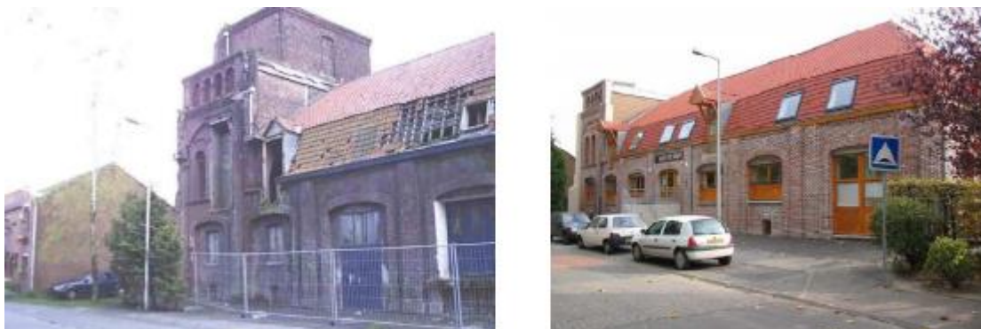
Figura 47: Maison des Sauvers, em Saint-André Lez Lille, na França, respectivamente, antes e depois da intervenção.
