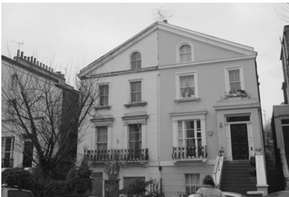
Figura 51: Fachada da Casa Vitoriana de Baixa Energia (LEVH – Low Energy Victorian House), em Camden, norte de Londres, sendo a metade esquerda de duas propriedades geminadas. Fonte: Cassar, 2009, p. 6.
