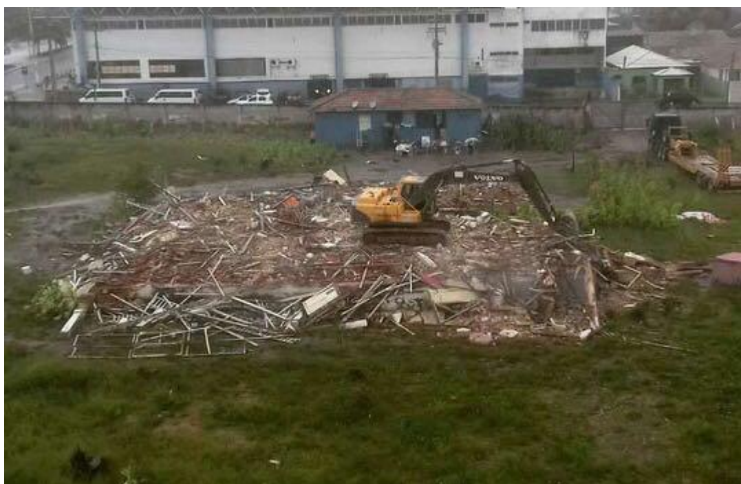
Figura 46: Demolição do Casarão dos Lungren
