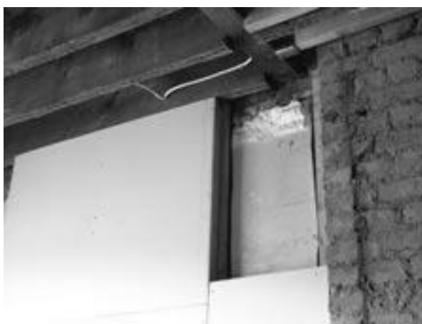
Figura 53: Detalhe mostrando a fixação de isolamento para a parede de tijolo sólido na Casa Vitoriana de Baixa Energia.
