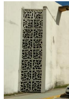
Figura 68 – Janela revestida com cobogós
