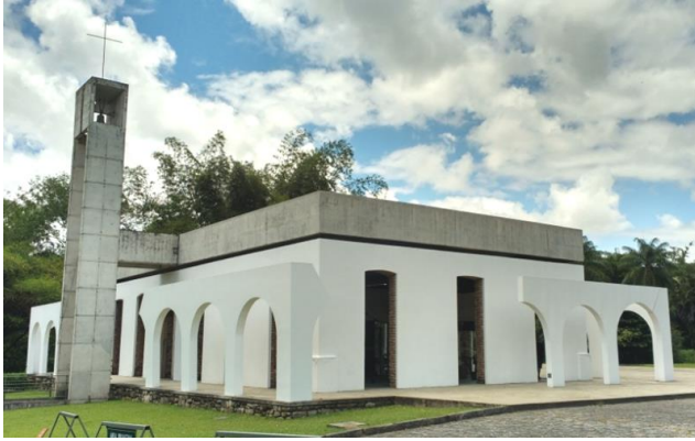
Figura 86 - Capela de Nossa Senhora da Conceição.
