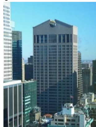
Figura 30 – Edifício da AT&T
