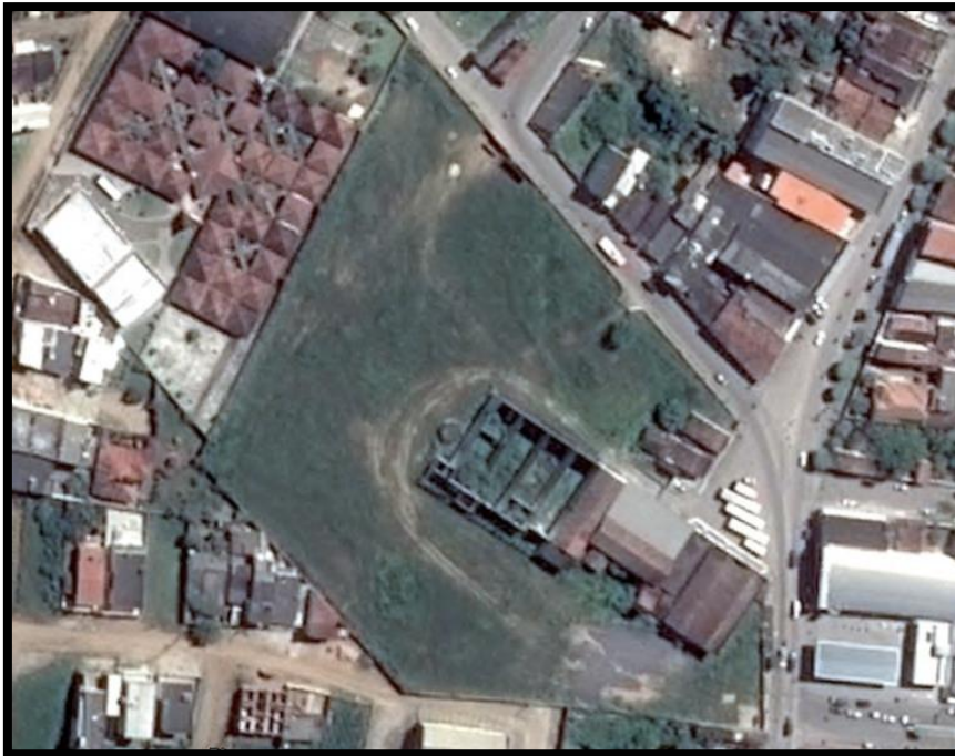
Figura 49: Foto aérea para análise da cobertura da Usina e Fabrica de óleo vegetal
