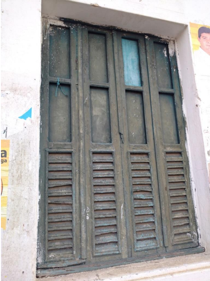
Figura 46: Perda de vidro e esquadrias em madeira mal conservadas e com desprendimento pictórico.
