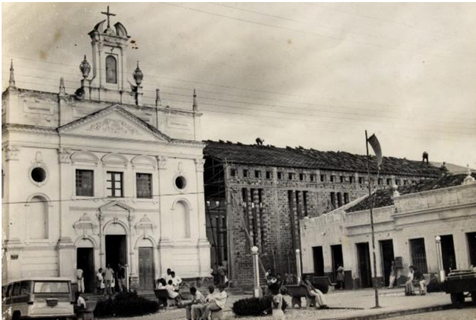
Figura 28: Templo São José (1916) e construção da Matriz São José
