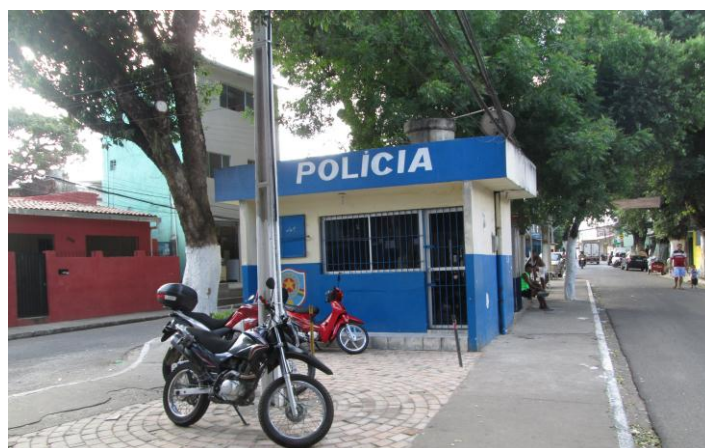
Figura 26: Posto policial desativado na Praça do Terminal
