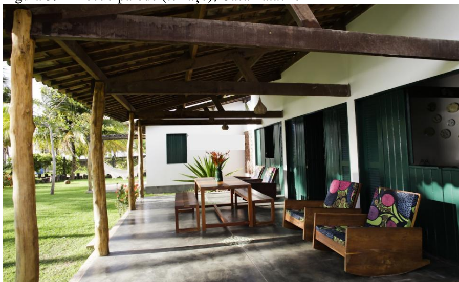
Figura 39 – Recuo parede (terraço), Casa Patacho
