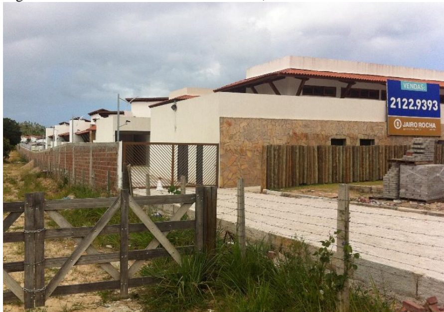
Figura 19 – Muros em toda extensão do lote, Club Meridional Carneiros
