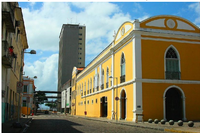
Figura 34 - Rua Madre de Deus com o imóvel designado ao Shopping Paço Alfândega. Resultante do Plano de Revitalização.
