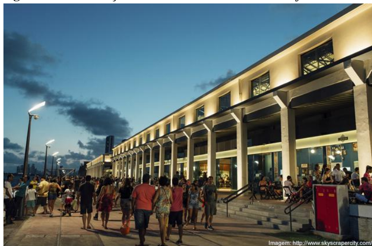
Figura 35 - Intervenção nos armazéns resultante do Projeto Porto Novo Recife.
