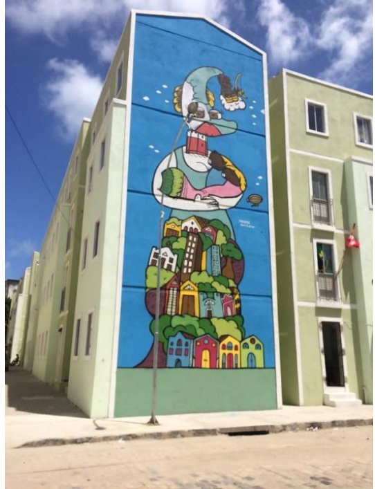
Figura 32 - Grafite na fachada bloco A.
