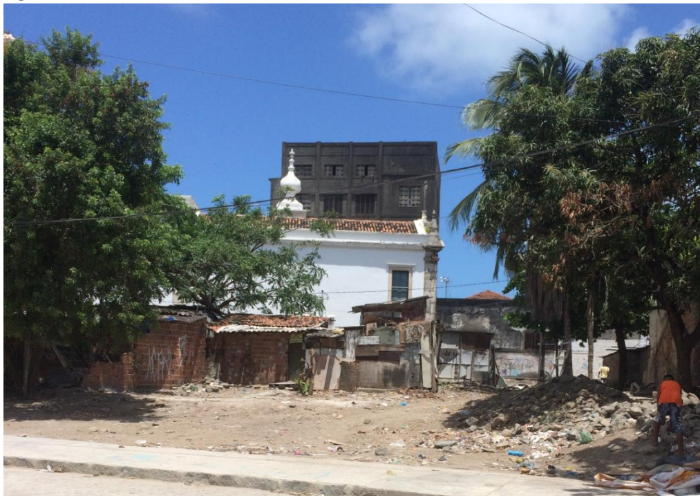
Figura 6 - Área com moradias demolidas, Comunidade do Pilar.
