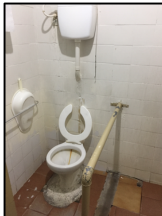
Figura 55. Banheiro com barras de apoio
