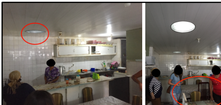
Figura 56. Cozinha com abertura do exaustor em destaque (E) e com mesas refeitorio em destaque (D)
