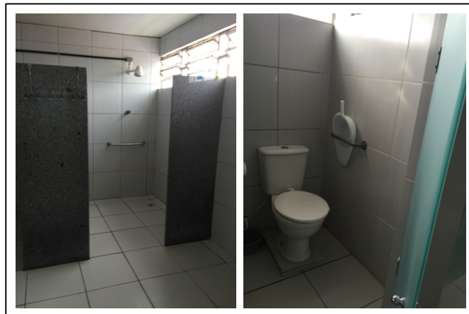
Figura 38. Banheiro: área de banho (E) e local do vaso sanitário (D)
