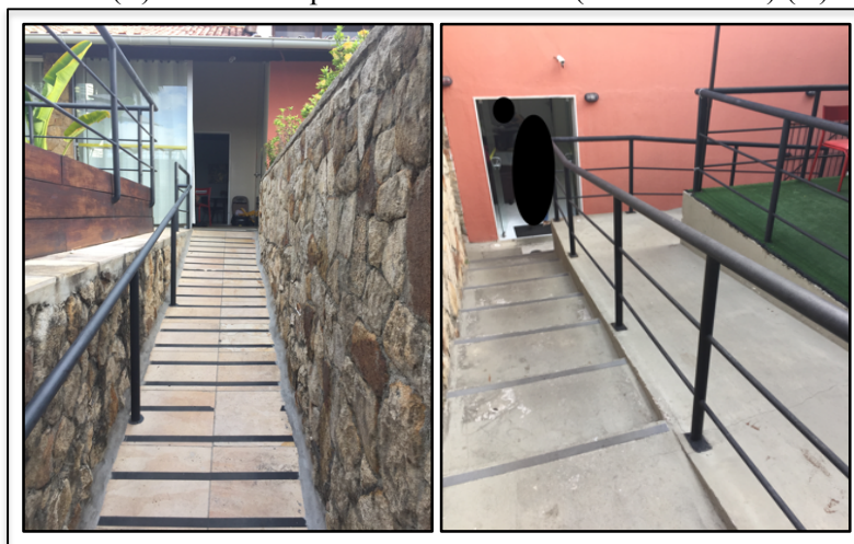
Figura 27. Rampas da entrada: subindo para o nível principal da casa (E) e descendo para o nível inferior (semienterrado) (D)
