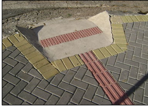
Figura 8. Piso tátil direcional e de alerta.
