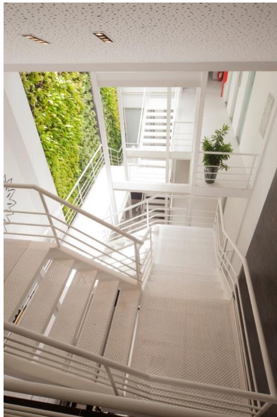
Figura 37: Escada em estrutura metálica localizada no pátio central
