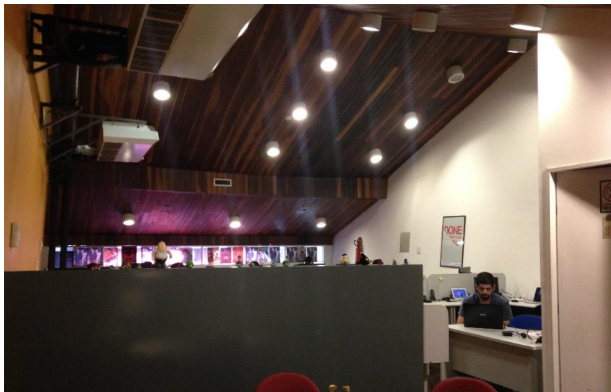
Figura 98 - último pavimento do imóvel Cais do Apolo nº 212, sem uso de forro de gesso
