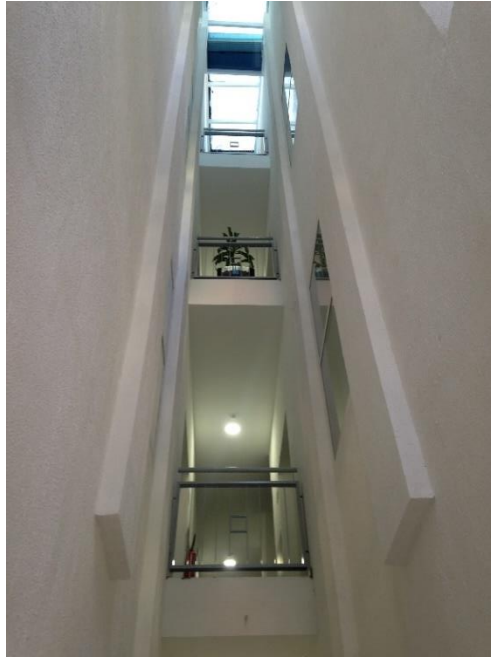
Figura 53: Beco interligando edificações, servindo como circulação entre as salas existentes nos pavimentos
