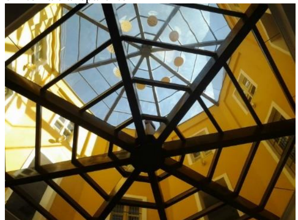
Figura 18: Vista central do imóvel com cobertura em telha transparente
