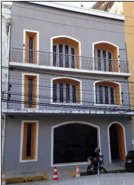
Figura 29: Fachada Rua do Brum
