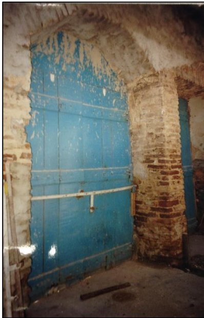
Figura 95 - Vista interna da porta central no térreo antes da restauração
