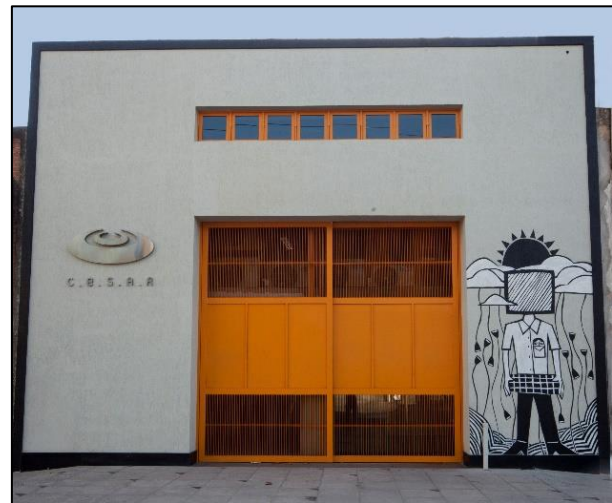
Figura 30: Fachada Cais do Apolo
