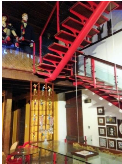
Figura 61: Escada em madeira e estrutura metálica
