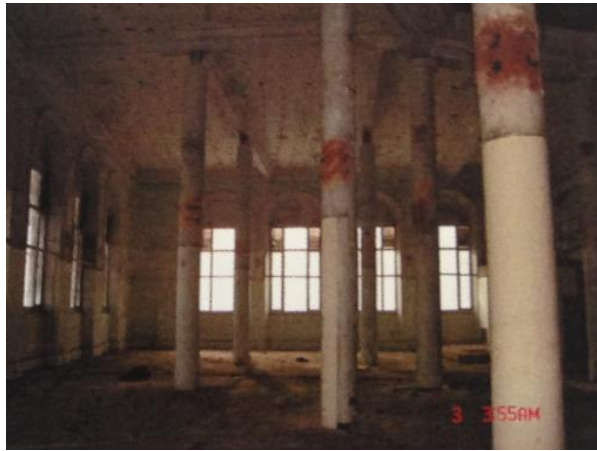
Figura 15: Pavimento térreo antes da reforma
