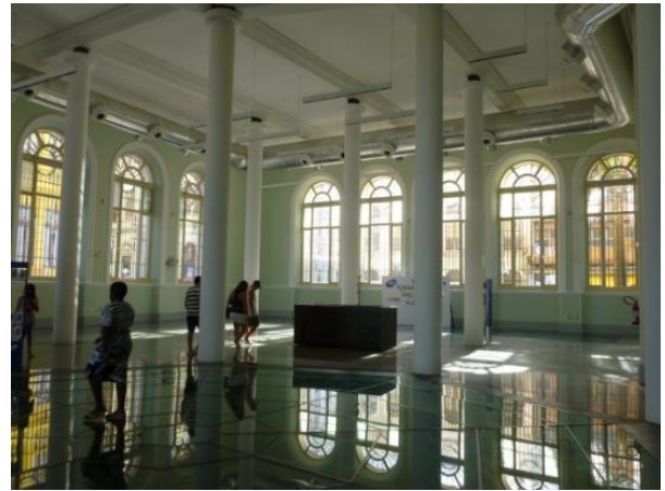
Figura 16: Pavimento térreo após reforma
