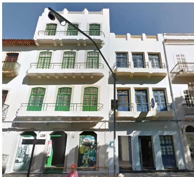
Figura 48 - Fachada Rua do Brum
