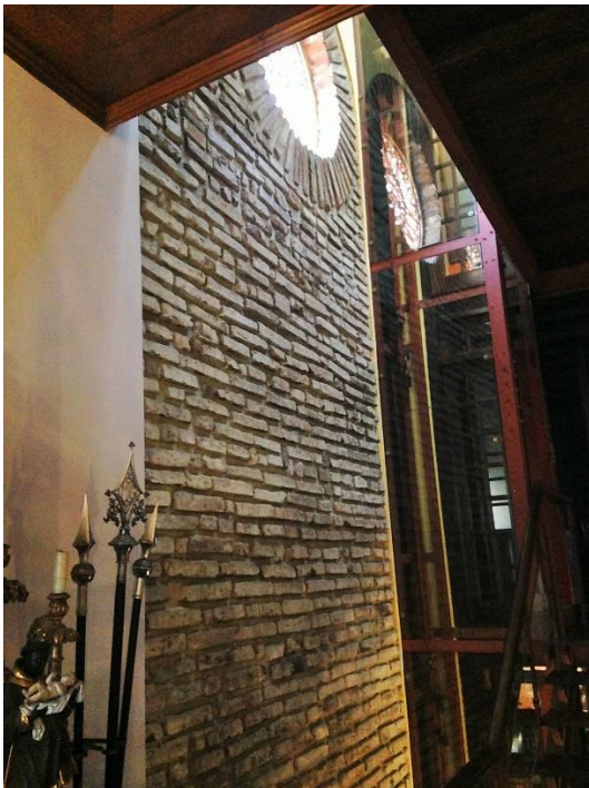
Figura 73 - Parede original com ornamentação nova
