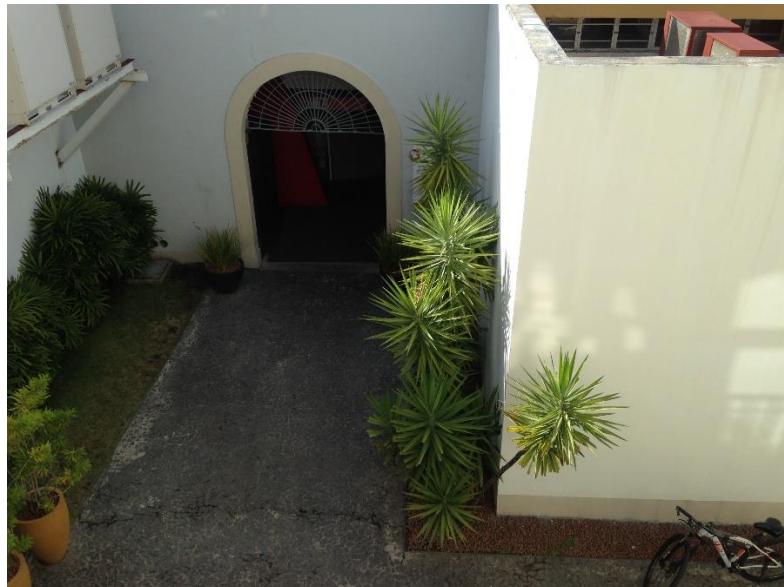
Figura 101 - Vista da interligação entre imóveis da Rua do Apolo com o do Cais do Apolo
