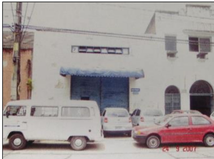
Figura 41: Fachada Cais do Apolo antes da reforma de 2013
