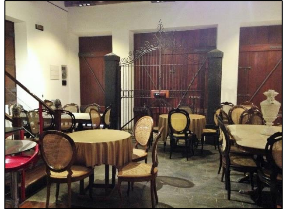
Figura 69 - Portas e gradis recuperados e portão em modelo clássico inserido no projeto
