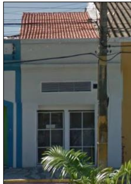
Figura 105 - Fachada Cais do Apolo
