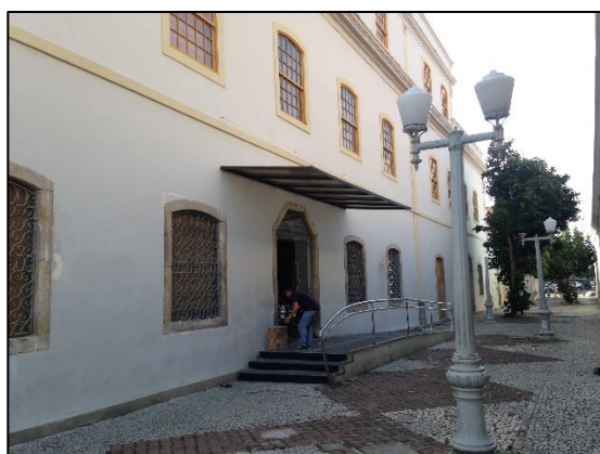
Figura 123 - Fachada após restauração
