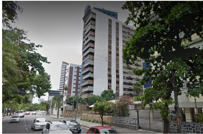
Figura 80 - Avenida Beira Rio, 2015.
