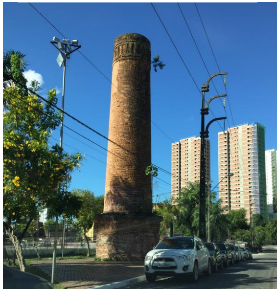
Figura 69 - Vista do Bueiro do Antigo Engenho.
