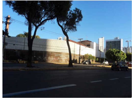
Figura 57 - Instalações do Antigo Banorte.
