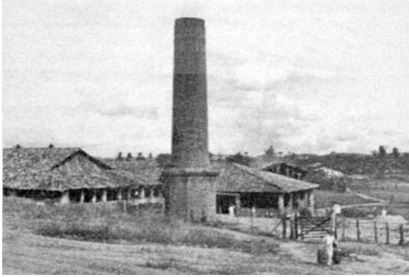
Figura 67 - Fábrica de Cerâmica da Torre - Antigo Fábrica do Engenho da Torre, início século XX.
