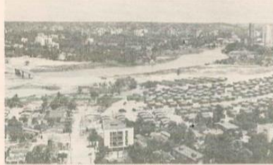
08 Durante a construção, ainda o contraste entre o ontem e o hoje.
