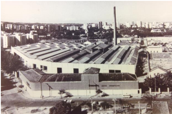
Figura 56 – Instalações do Banorte.
