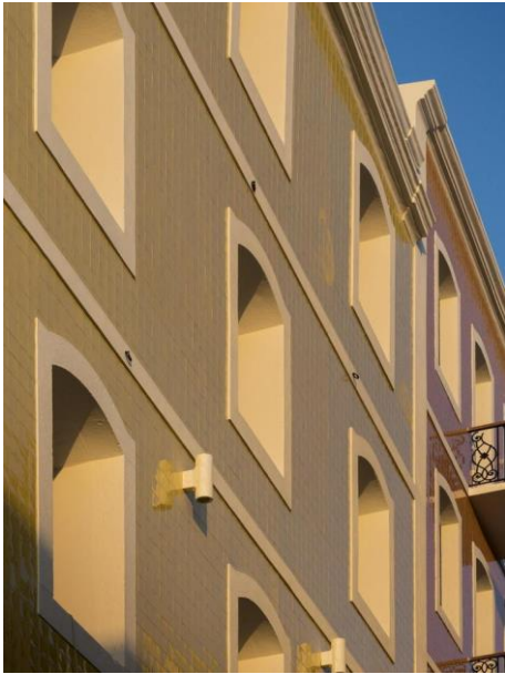
Figura 45 - Fachada restaurada com azulejos com ritmo presente nas janelas
