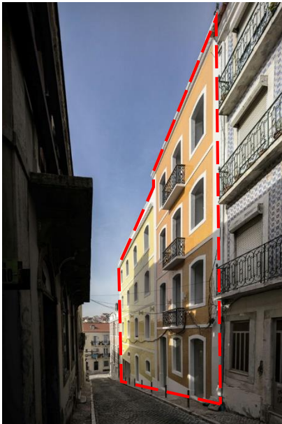
Figura 41 - Fachada da edificação
