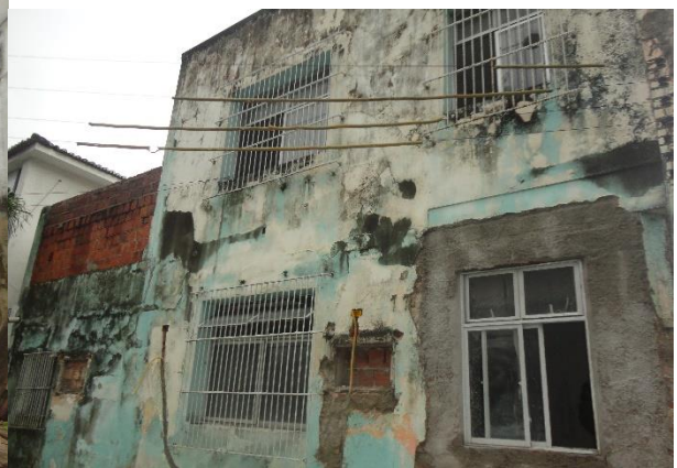
Figura 36 - CEP feminina em obra, fachada para a Rua Amaury Medeiros
