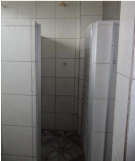
Figura 23 - Boxe do chuveiro não permite a entrada de cadeirantes
