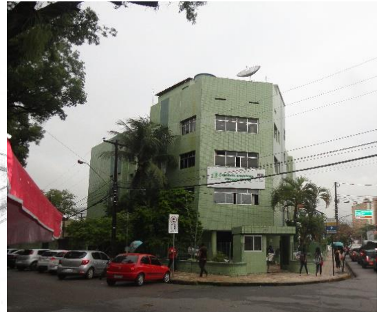
Figura 18 - Fachada da CEP
