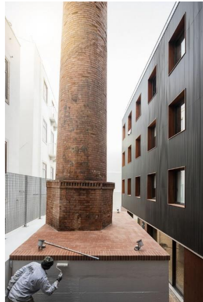
Figura 42 - Chaminé restaurada da antiga fábrica
