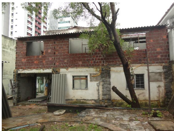
Figura 35 - CEP feminina em obra
