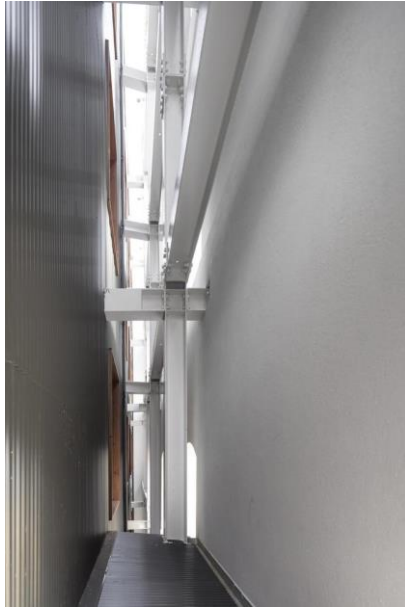
Figura 43 - Fachada restaurada presa ao prédio novo pela estrutura metálica
