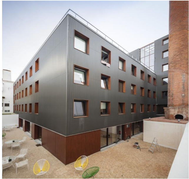
Figura 46 - Fachadas dos novos prédios mantendo o ritmo das janelas
