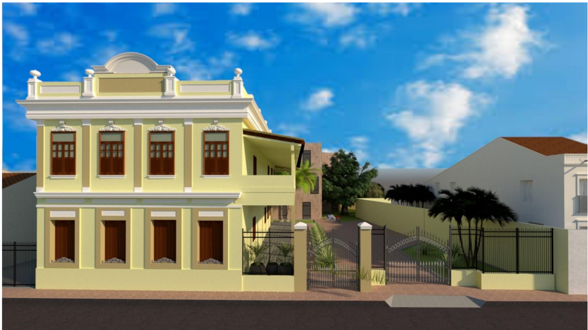
Figura 62 - Fachada da edificação
