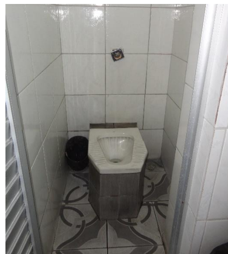
Figura 22 - Boxe com bacia sanitária do tipo turca sobre apoio
