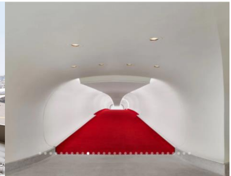
Foto 10: Tubo de acesso entre o lobby, bloco dos quartos e terminal 5
