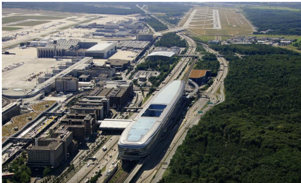
Foto 13: Conexão entre o The Squire e o Aeroporto Internacional de Frankfurt
