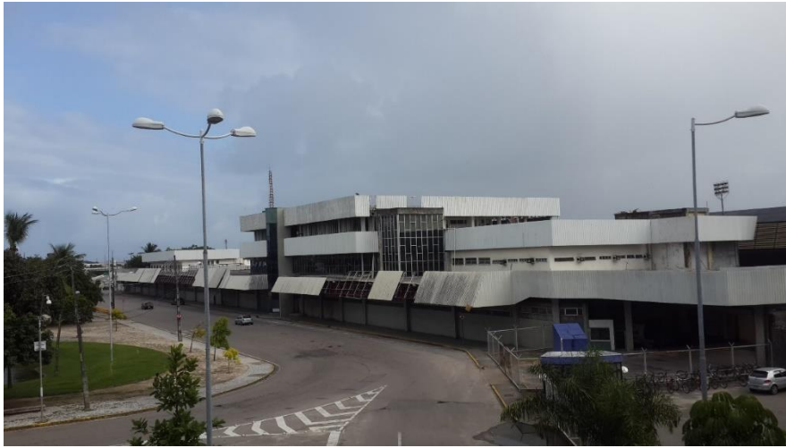
Foto 45: Intervenção descaracterizadora na antiga sede do Aeroporto dos Guararapes.
