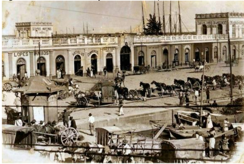
Figura 2: Início da construção do mercado público
