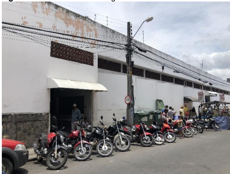
Figura 13: Fachada com cobogós
