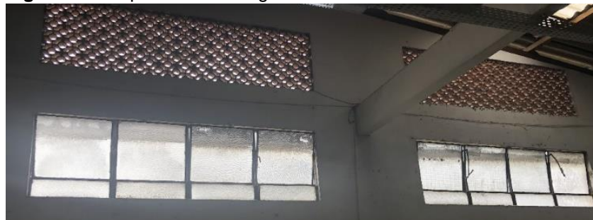
Figura 16: Esquadrias e cobogós
