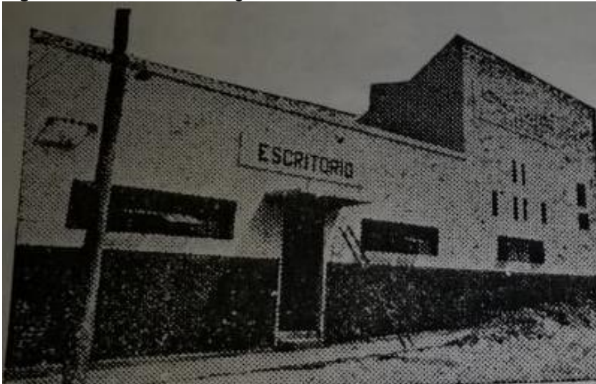
Figura 11: Edifício da usina geradora de eletricidade em Garanhuns
