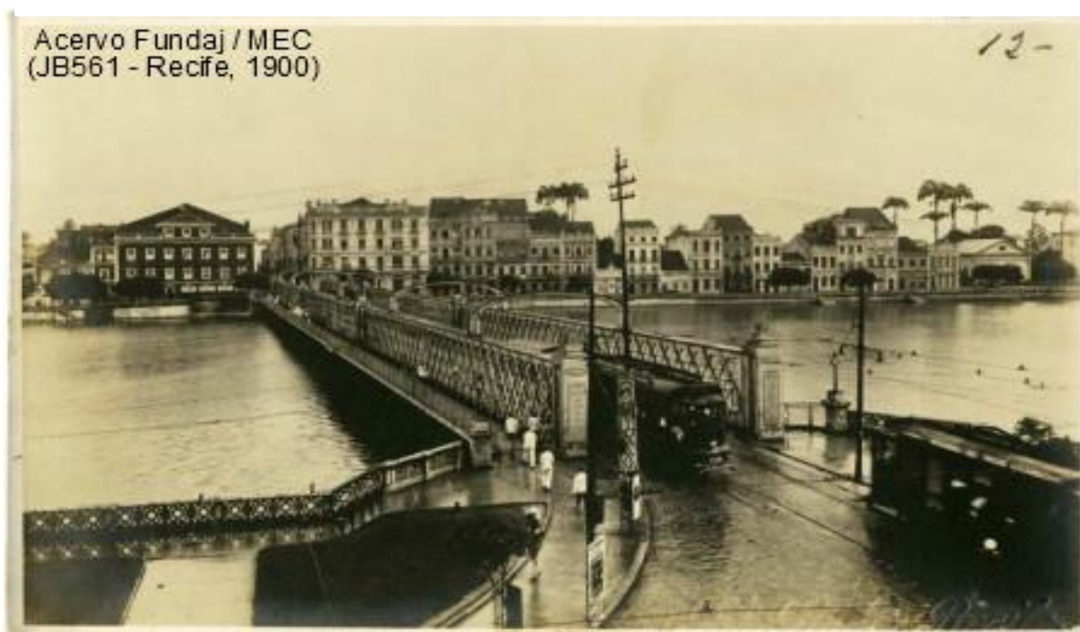
Figura 7: Ponte da Boa Vista, Recife-PE
