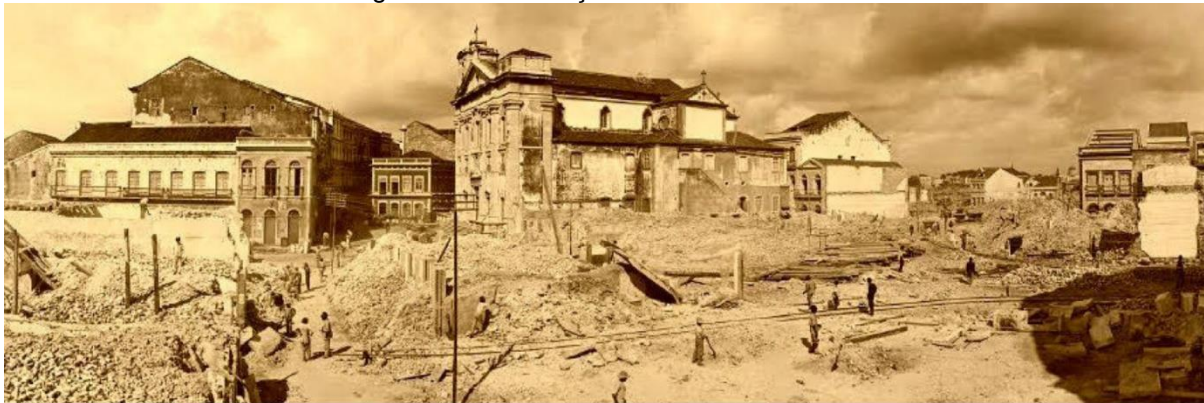
Figura 21 – Demolições do Bairro do Recife
