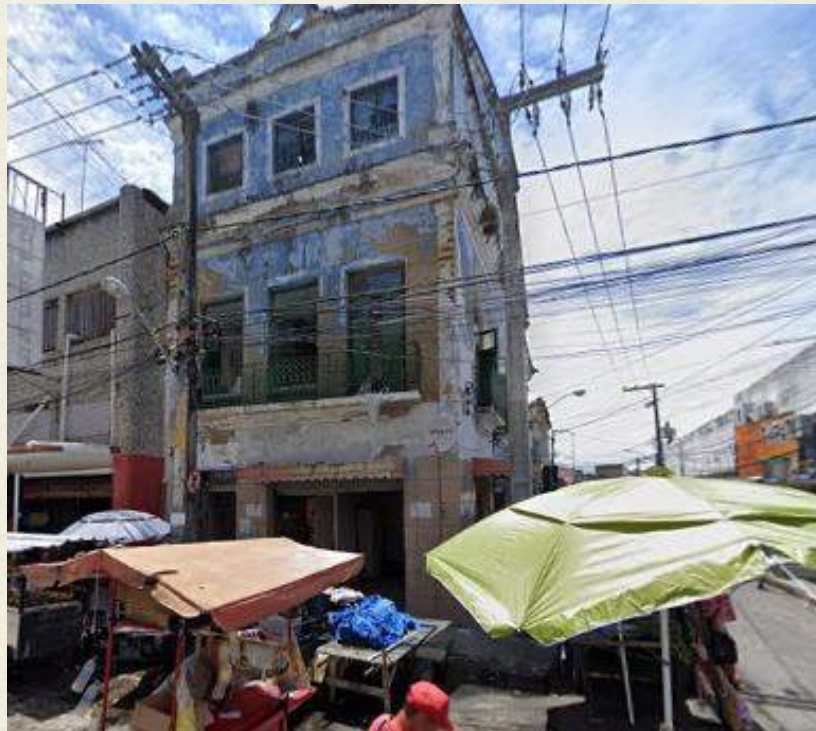
Figura 22 – Imóvel na Rua da Palma, bairro Santo Antônio, Recife.
