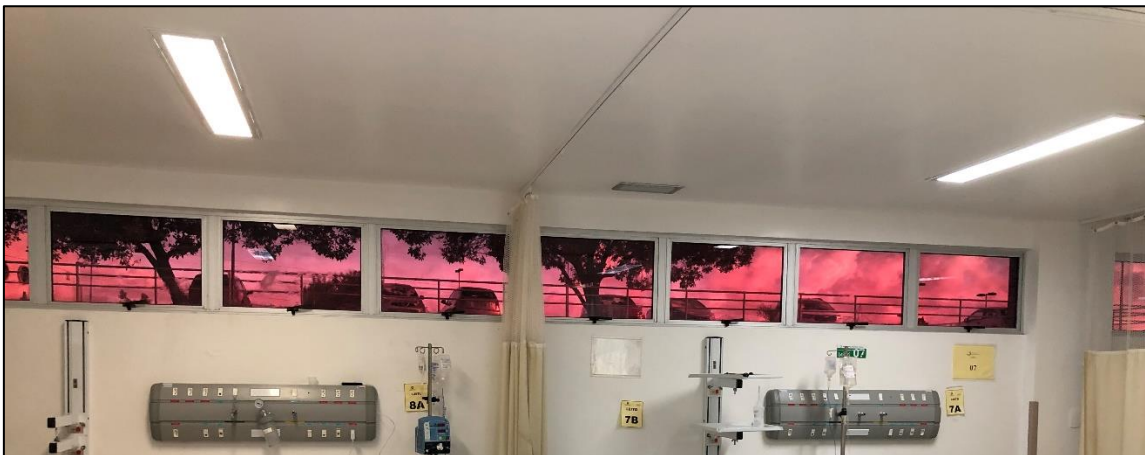
Figura 35. Janelas da Sala Amarela 2 (Internamento)
