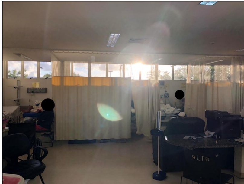
Figura 26. Janelas da Sala Amarela 1 com presença de ofuscamento (foto 4)
