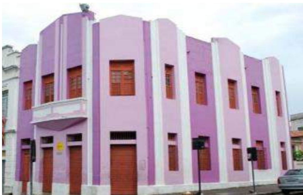
Figura 25 - Exemplar do grupo de escalonamento, Praça Antenor Navarro, João Pessoa- PB
