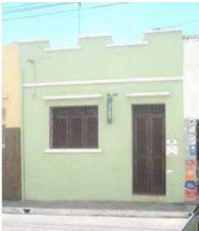
Figura 24 - Exemplar do grupo reformas, na Avenida General Osorio, João Pessoa- PB
