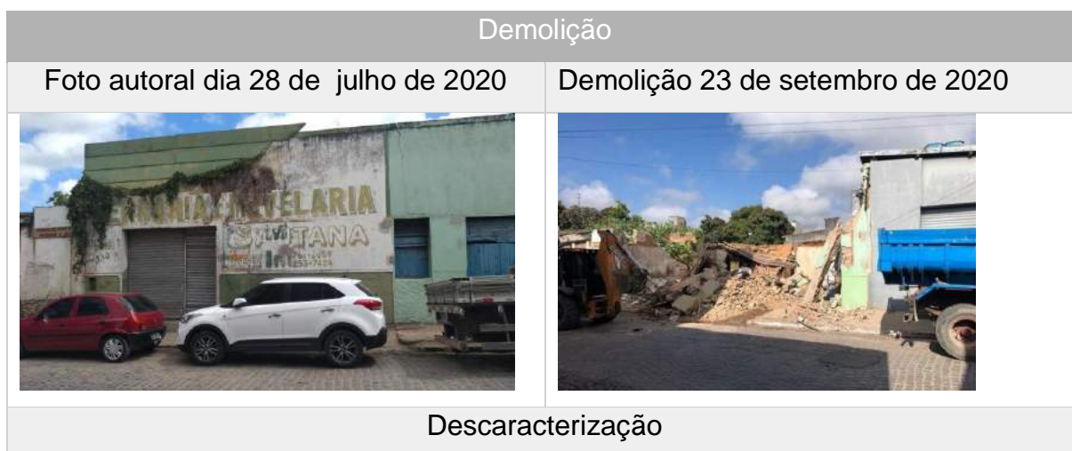
Quadro 9 – Exemplares de descaracterização
