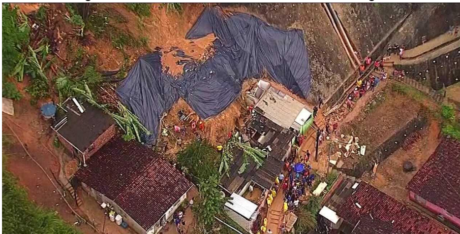
Figura 13 : Deslizamento de barreira em Camaragibe
