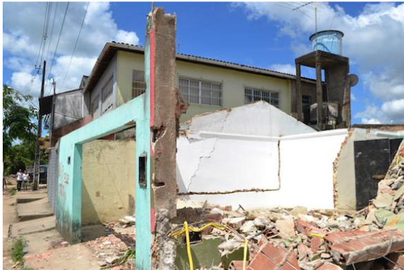
Figura 14: Remoções para as obras da Copa
