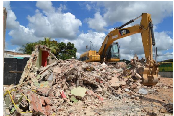
Figura 15: Remoções para as obras da Copa
