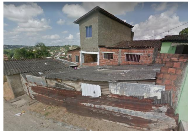
Figura 50: Rua João Ribeiro Nabuco
