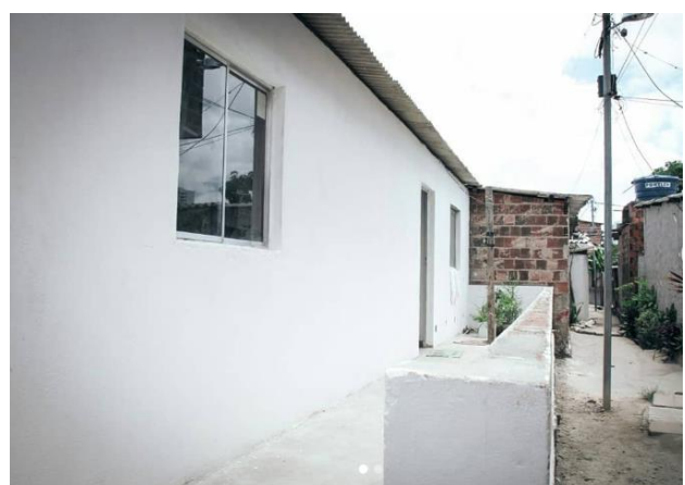
Figura 27: Casa depois da reforma
