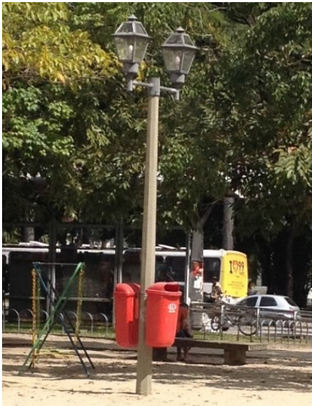
FIGURA 20: Iluminação da Praça do Derby.
