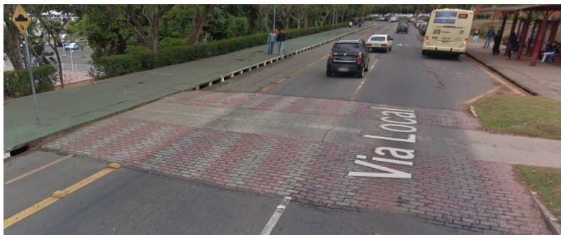
FIGURA 90: Travessia elevada para pedestres com piso tátil
