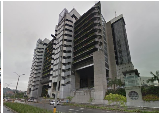
FIGURA 51: Edifício inteligente EPM.
