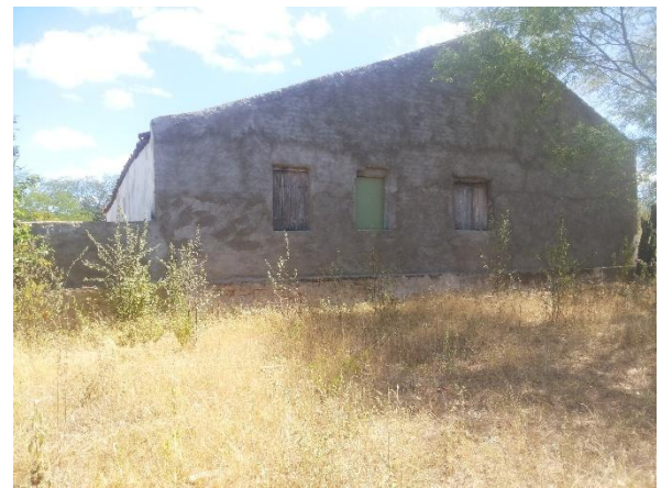
FIGURA 162 – Fachada Lateral Esquerda
