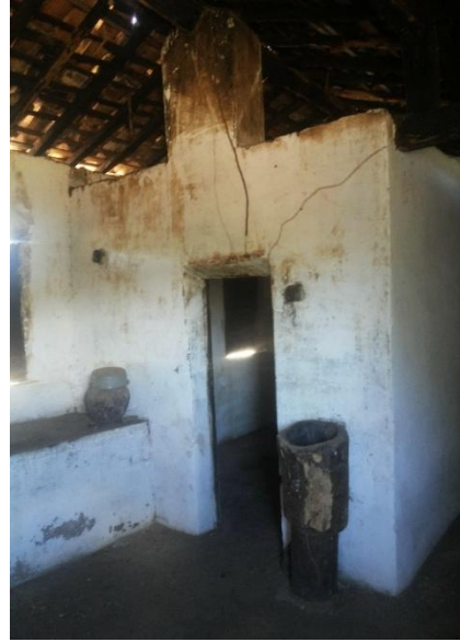
FIGURA 166 – Detalhe estrutura da coberta
