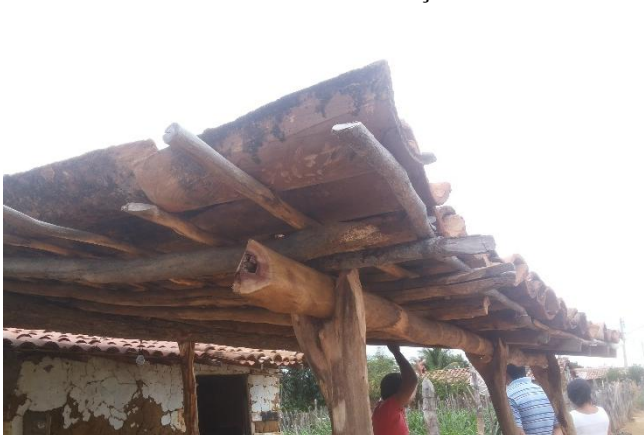
FIGURA 101 – Detalhe telhas de fabricação manual
