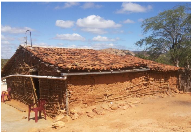
FIGURA 154 – Fachada Lateral Direita
