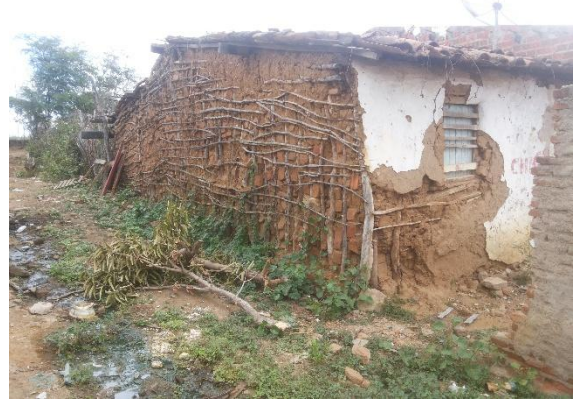
FIGURA 72 – Fachada Lateral esquerda
