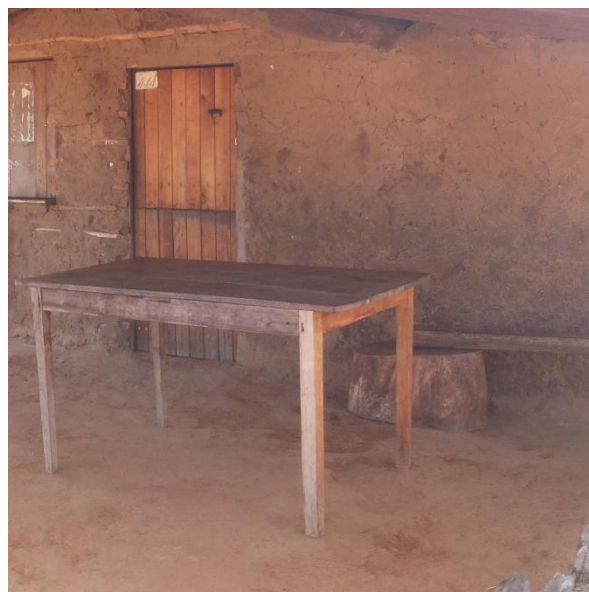
FIGURA 150 – Detalhe parede fachada
