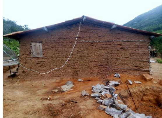
FIGURA 227 – Fachada Lateral Esquerda
