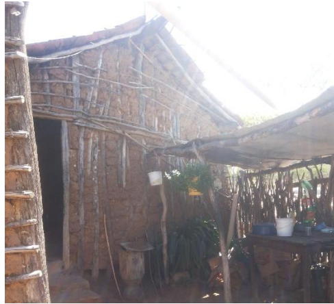
FIGURA 172 – Fachada Lateral Esquerda
