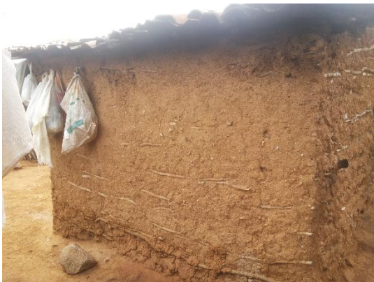
FIGURA 59 – Fachada Lateral Direita
