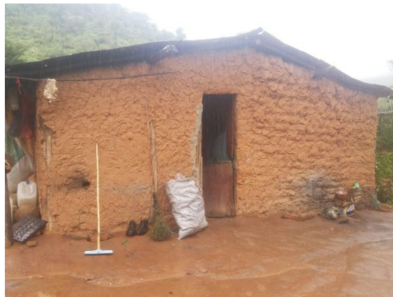
FIGURA 206 – Fachada Lateral Esquerda
