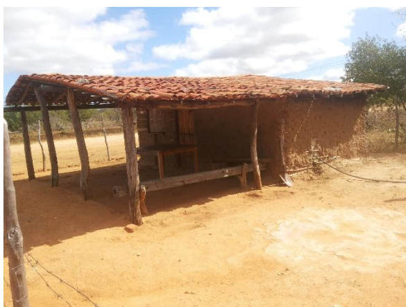
FIGURA 147 – Fachada Lateral Direita
