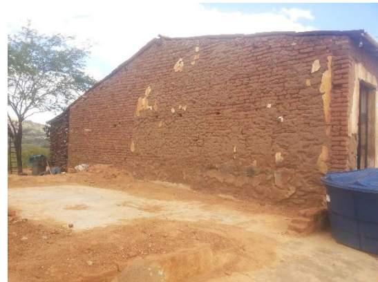
FIGURA 189 – Fachada Lateral Esquerda
