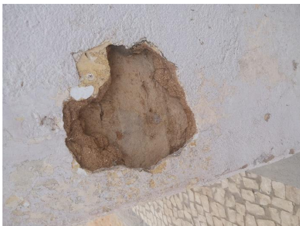
FIGURA 143 – Detalhe estrutura da parede
