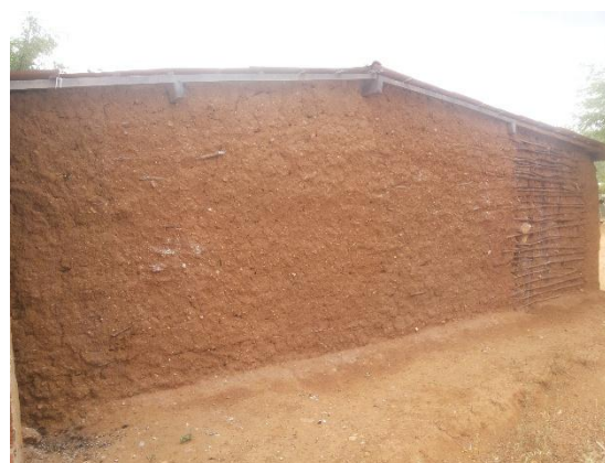
FIGURA 46 – Fachada Lateral Esquerda
