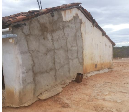
FIGURA 89 – Fachada Lateral Direita
