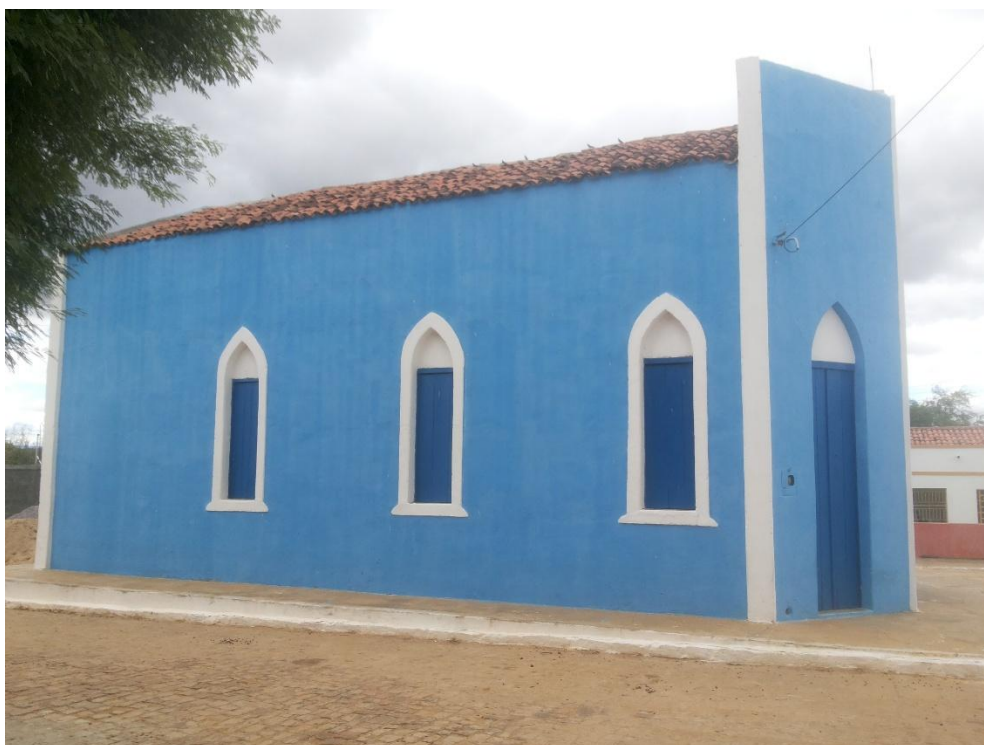
FIGURA 137 – Fachada Lateral esquerda
