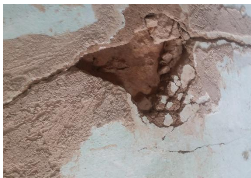
FIGURA 93 – Detalhe da parede interna
