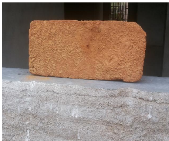
FIGURA 134 – Tijolo utilizado nas paredes
