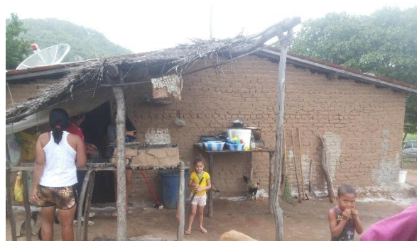
FIGURA 199 – Fachada Lateral Esquerda
