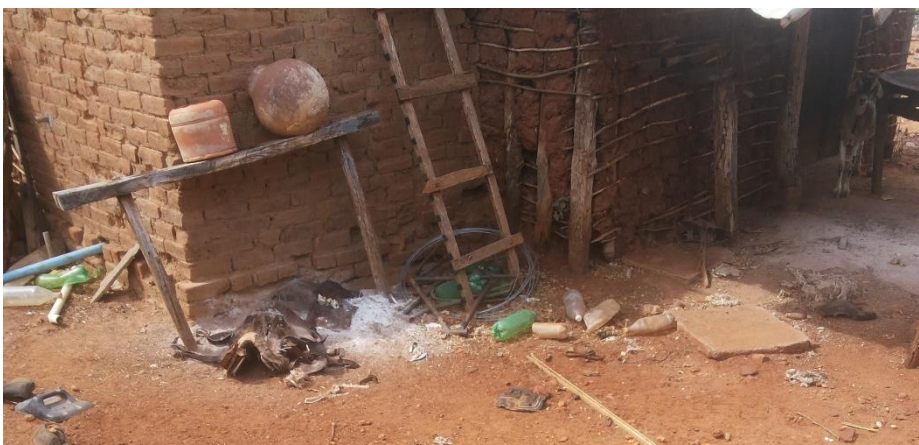
FIGURA 129 – Detalhe estrutura da parede
