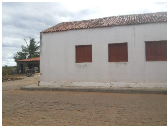
FIGURA 142 – Fachada Lateral Esquerda
