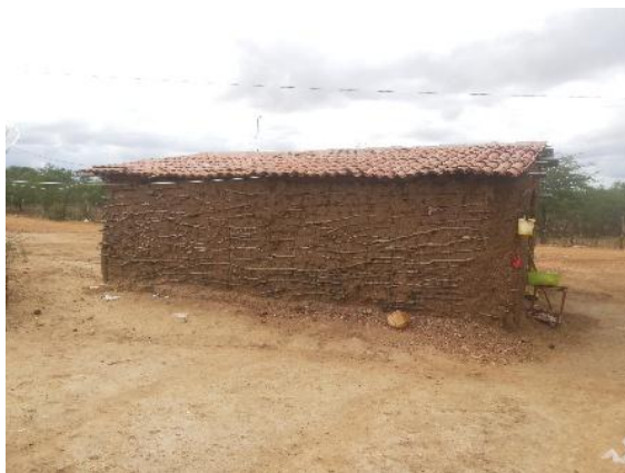
FIGURA 52 – Fachada Lateral Direita
