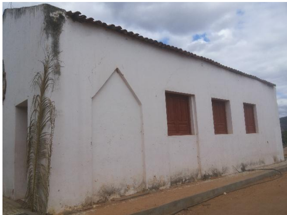
FIGURA 141 – Fachada Lateral Direita
