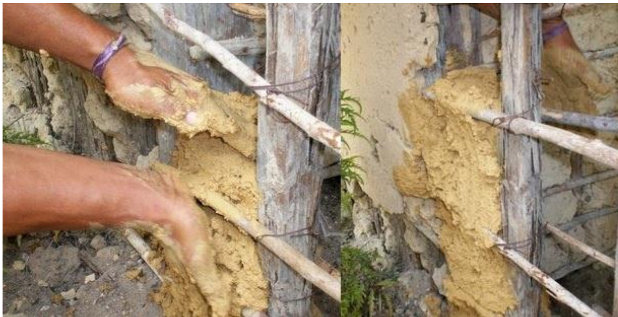
FIGURA 11 – Preenchimento com barro externamente e internamente
