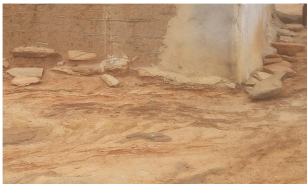
FIGURA 92 – Fachada Fundação em pedra
