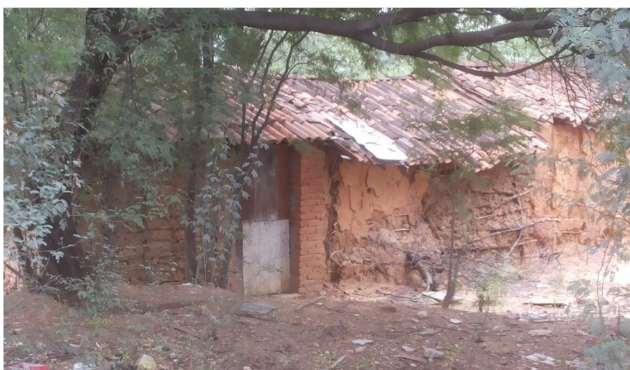
FIGURA 79 – Fachada Lateral Esquerda
