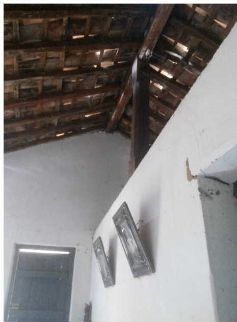
FIGURA 121 – Detalhe da cobertura
