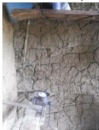
FIGURA 102 – Detalhe parede int.
