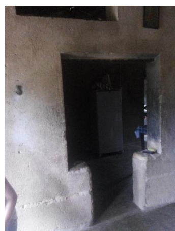
FIGURA 215 – Detalhe da parede
