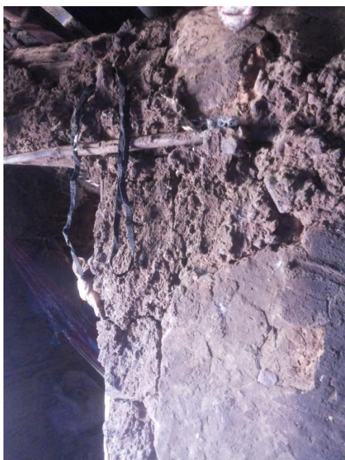
FIGURA 156 – Detalhe revestimento da parede interna
