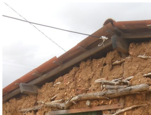
FIGURA 55 – Detalhe estrutura da cobertura
