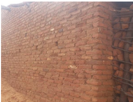
FIGURA 191 – Detalhe parede externa
