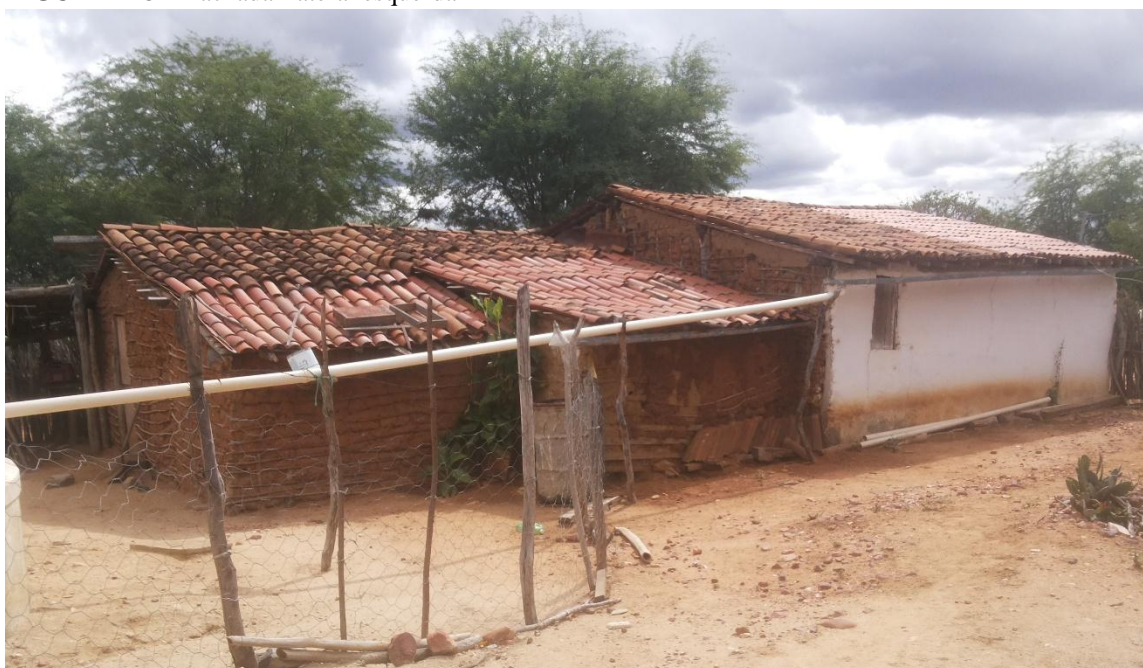
FIGURA 113 – Fachada Lateral esquerda
