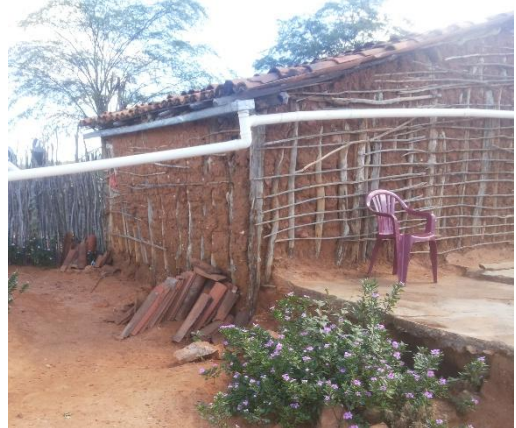
FIGURA 155 – Fachada Lateral Esquerda
