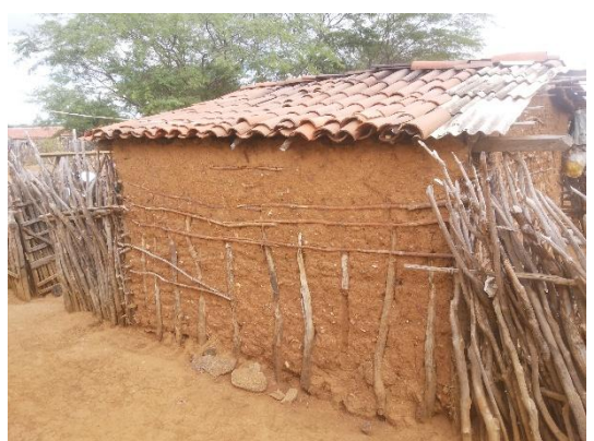
FIGURA 60 – Fachada Lateral Esquerda
