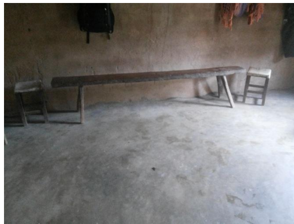
FIGURA 213 – Detalhe piso e parede interna
