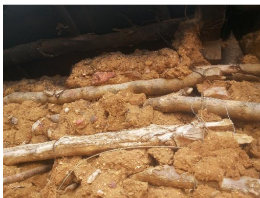
FIGURA 62 – Detalhe estrutura da parede
