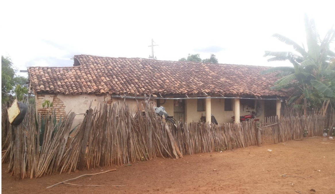
FIGURA 119 – Fachada Lateral esquerda
