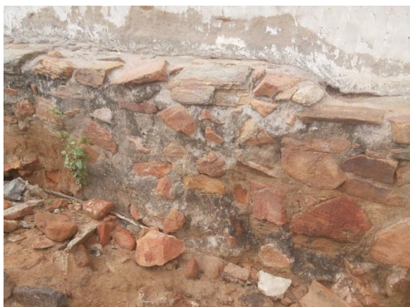
FIGURA 182 – Detalhe fundação em pedra
