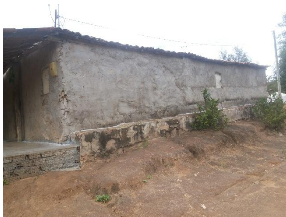
FIGURA 219 – Fachada Lateral Direita
