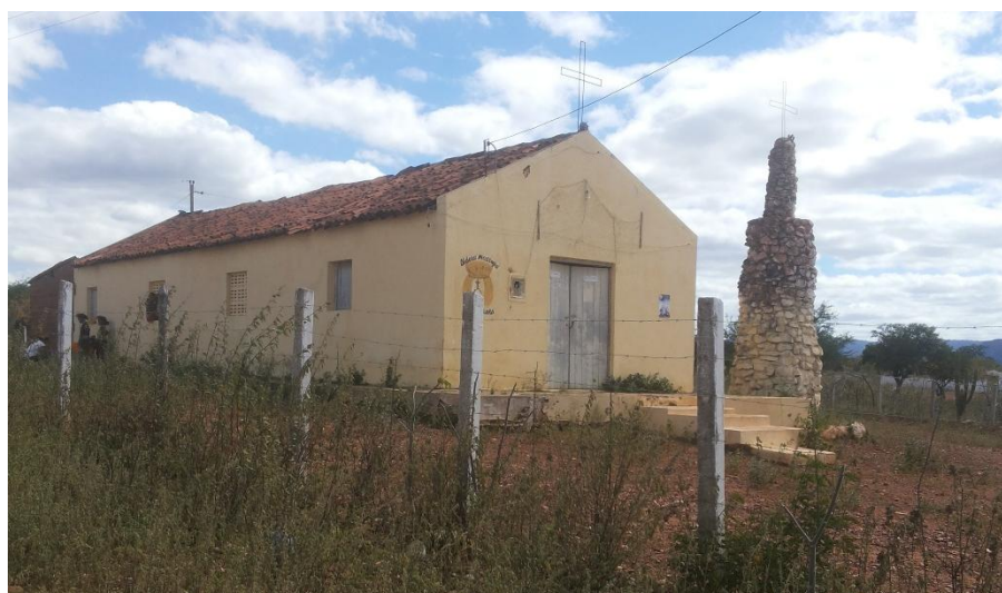
FIGURA 194 – Fachada Lateral Esquerda
