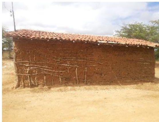
FIGURA 53 – Fachada Lateral Esquerda
