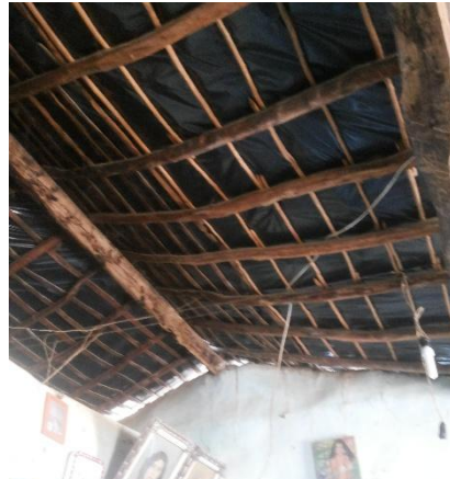
FIGURA 91 – Detalhe da cobertura
