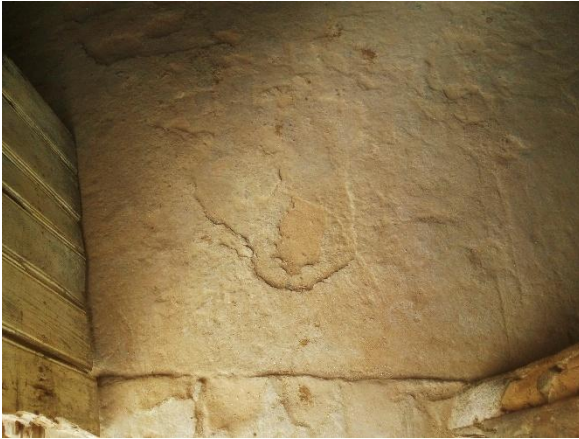
FIGURA 75 – Detalhe do piso
