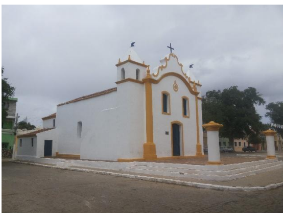
FIGURA 82 – Fachada Lateral Esquerda
