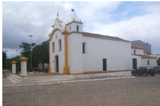
FIGURA 81 – Fachada Lateral Direita
