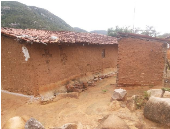
FIGURA 220 – Fachada Lateral Esquerda
