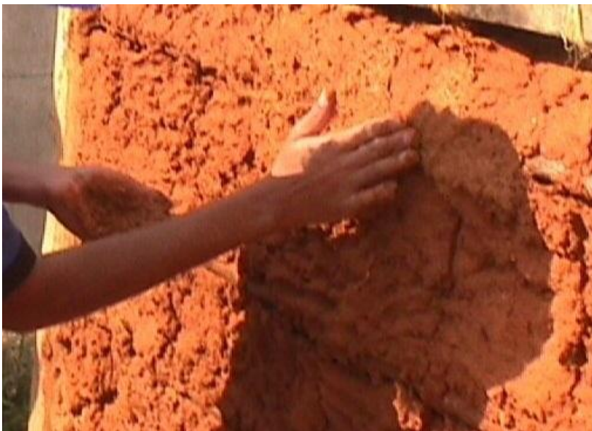
FIGURA 9 – Pressionando o barro entre as frestas
