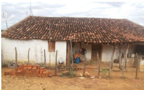
FIGURA 180 – Fachada Lateral Direita
