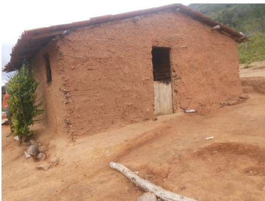
FIGURA 226 – Fachada Lateral Direita
