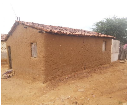
FIGURA 105 – Fachada Lateral direita
