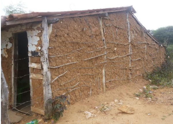
FIGURA 97 – Fachada Lateral Direita
