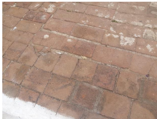
FIGURA 83 – Detalhe piso tijolos maciços
