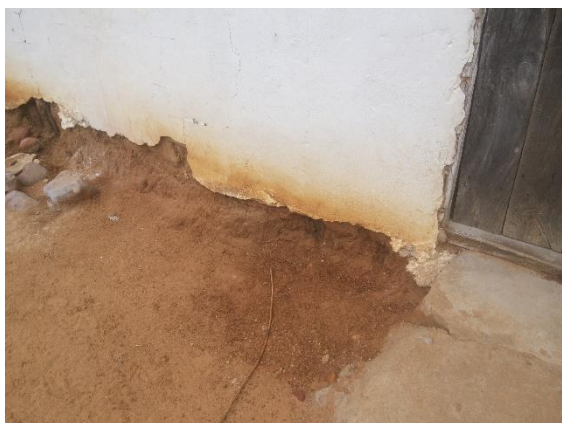
FIGURA 114 – Detalhe da parede
