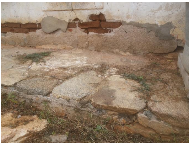
FIGURA 133 – Detalhe parede e fundação em pedra
