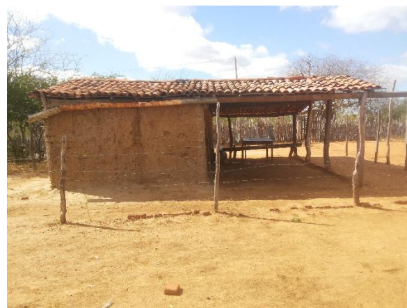
FIGURA 148 – Fachada Lateral Esquerda
