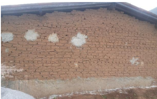
FIGURA 198 – Fachada Lateral Direita
