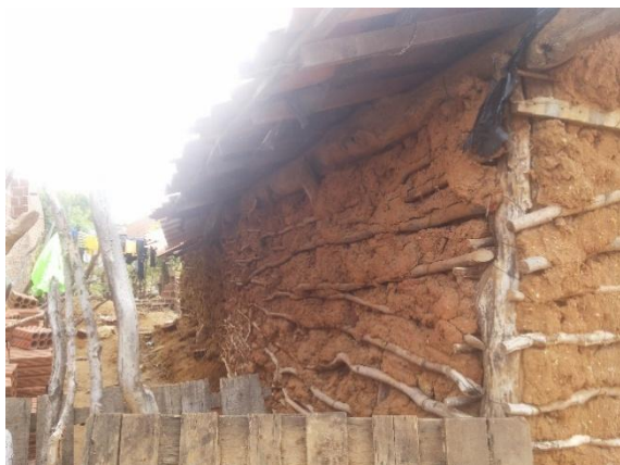
FIGURA 66 – Fachada Lateral Esquerda
