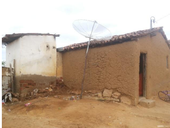
FIGURA 106 – Fachada Lateral Esquerda
