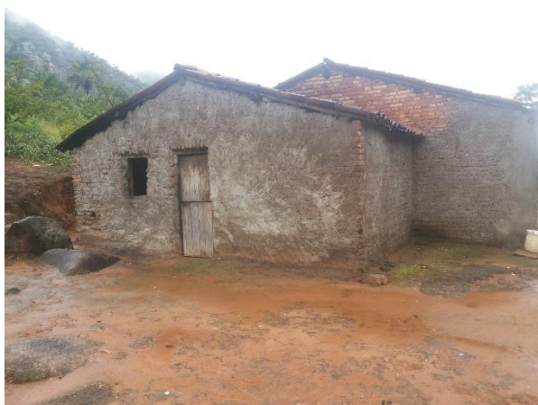
FIGURA 212 – Fachada Lateral Esquerda
