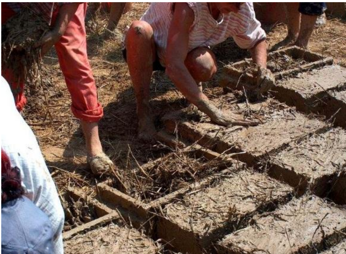
FIGURA 19 – Formando os tijolos de adobe
