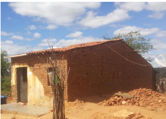
FIGURA 188 – Fachada Lateral Direita
