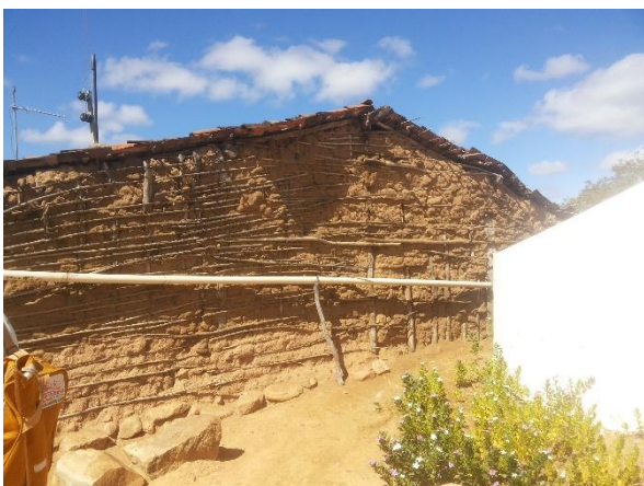
FIGURA 171 – Fachada Lateral Direita
