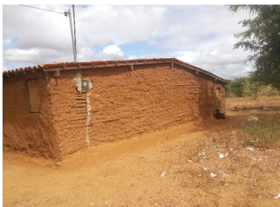
FIGURA 45 – Fachada Lateral Direita
