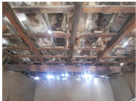
FIGURA 74 – Estrutura da cobertura
