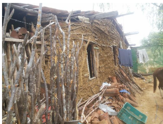
FIGURA 98 – Fachada lateral esquerda
