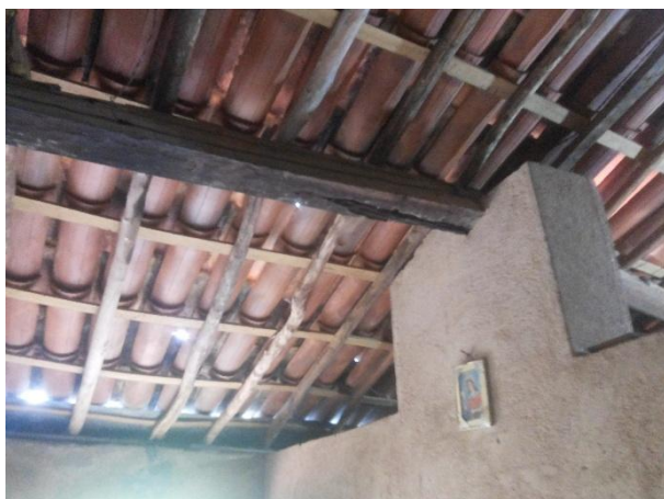
FIGURA 214 – Detalhe da cobertura
