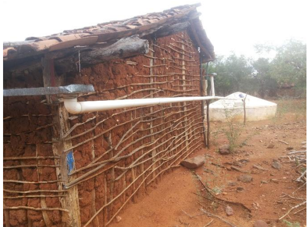
FIGURA 128 – Fachada Lateral Esquerda
