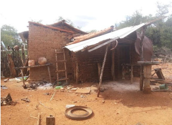
FIGURA 127 – Fachada Lateral direita
