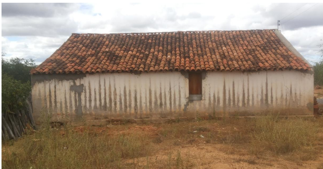
FIGURA 132 – Fachada Lateral direita
