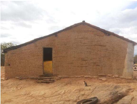
FIGURA 90 – Fachada Lateral Esquerda
