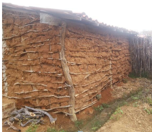
FIGURA 65 – Fachada Lateral Direita
