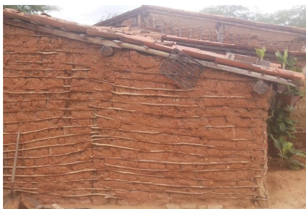
FIGURA 115 – Detalhe da parede
