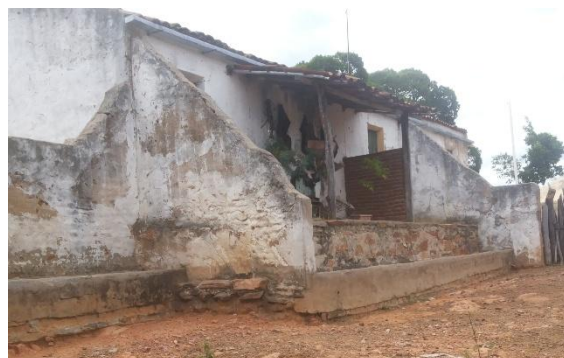
FIGURA 181 – Fachada Lateral Esquerda
