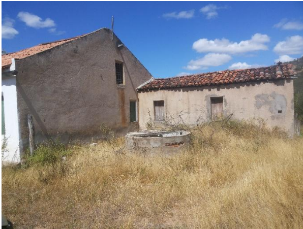
FIGURA 161 – Fachada Lateral Direita
