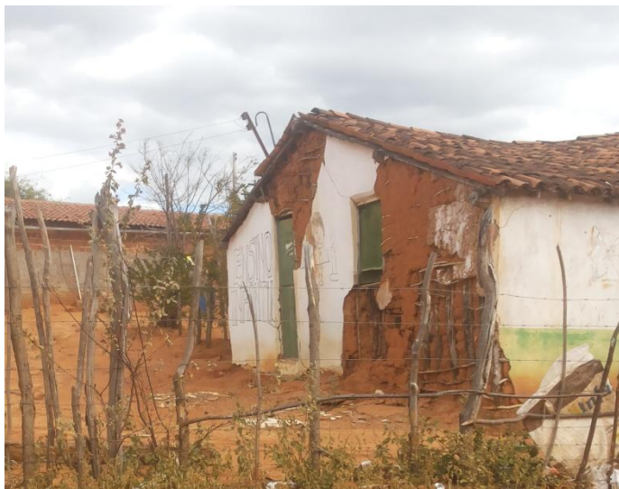
FIGURA 232 – Escola construída em Pau-a-Pique, revestida em areia e cal
