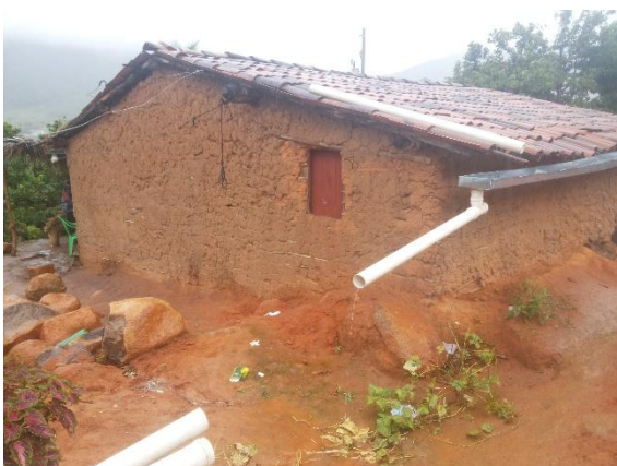
FIGURA 205 – Fachada Lateral Direita
