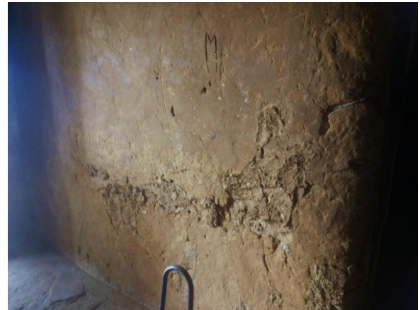
FIGURA 76 – Detalhe parede interna
