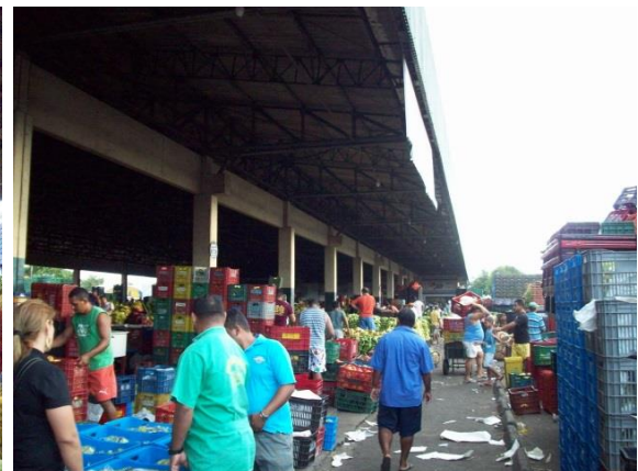
Figura 26 - Foto dos galpões em funcionamento (FONTE: Autor, 2014).
