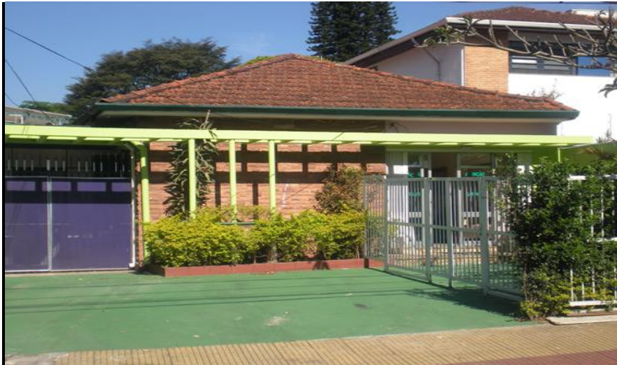
FIGURA 36 – Fachada - Residencial Geriátrico Melhor Idade
