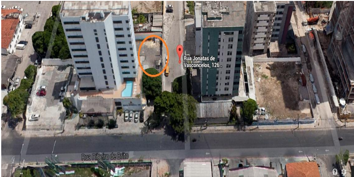
FIGURA 68 – Vista aérea do Conviver Geriátrico
