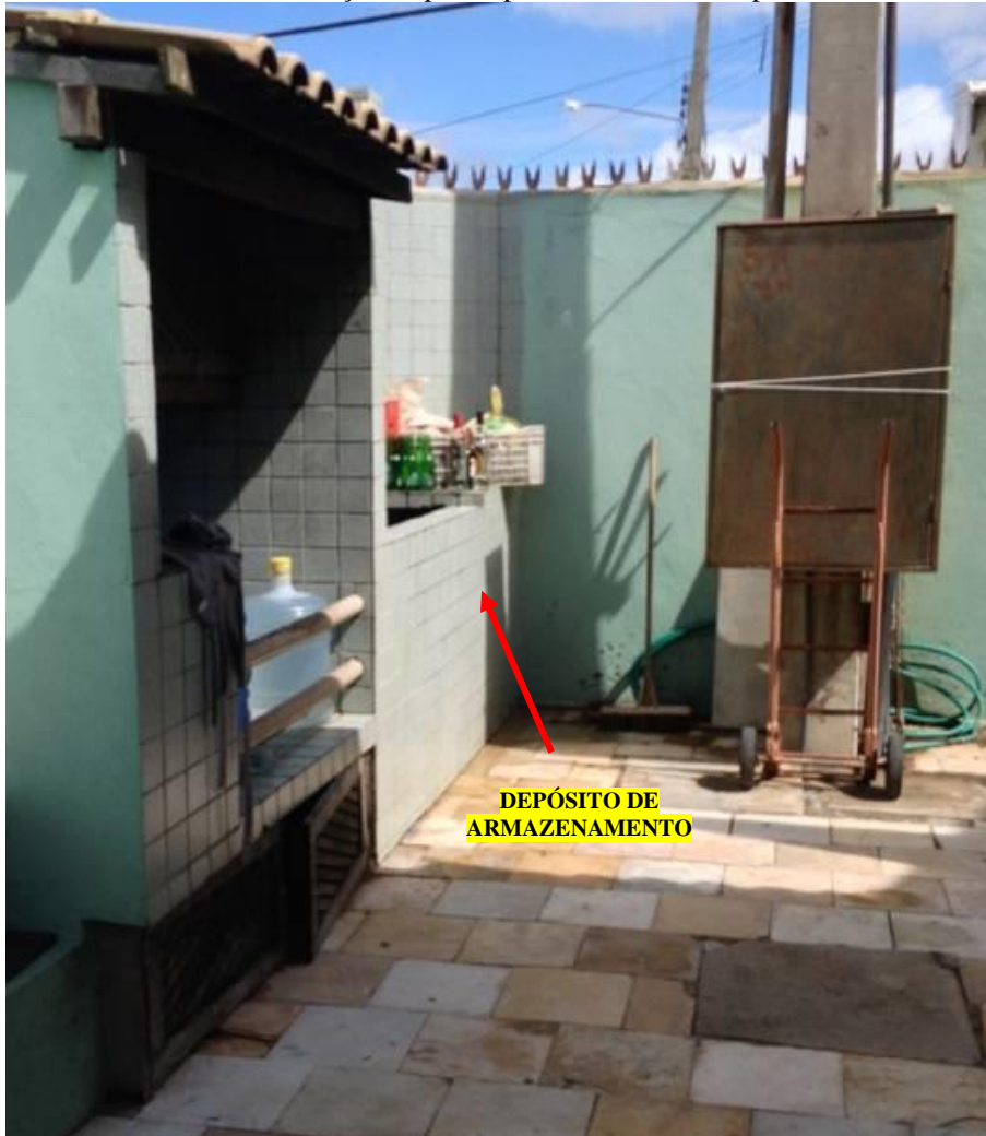
FIGURA 37 – Área de serviço e depósito para armazenamento para coleta seletiva.
