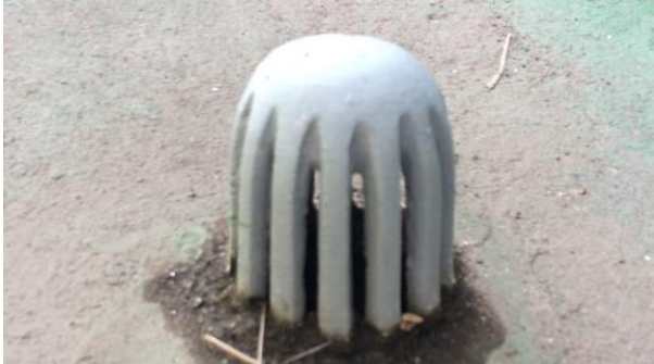
FIGURA 84 – Captadores de águas de chuva.
