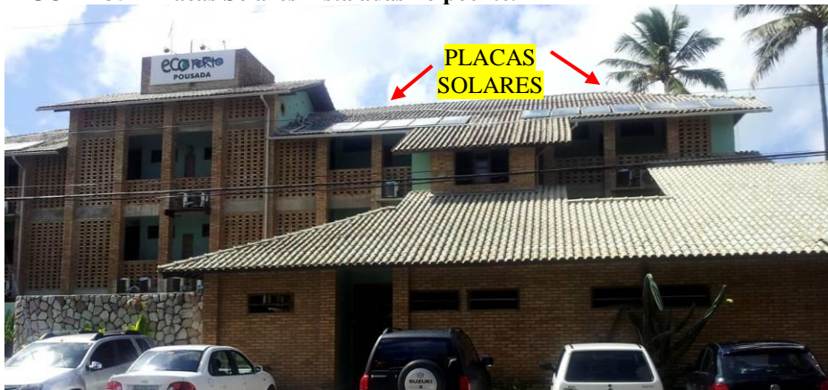
FIGURA 35 – Placas Solares instaladas no poente.
