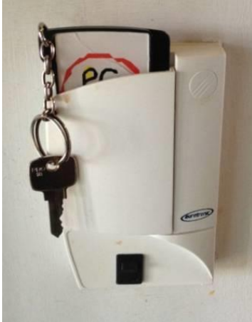
FIGURA 38 – Cartão de energia.
