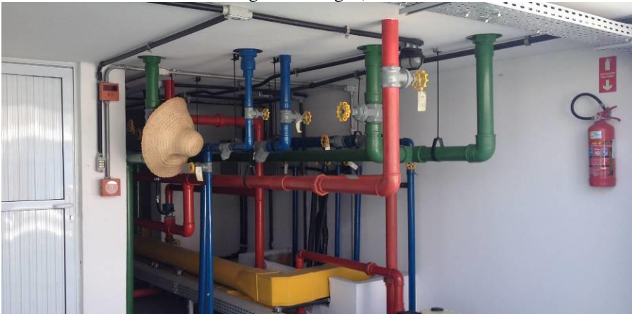
FIGURA 82 – Misturadores e registros de água, no telhado.
