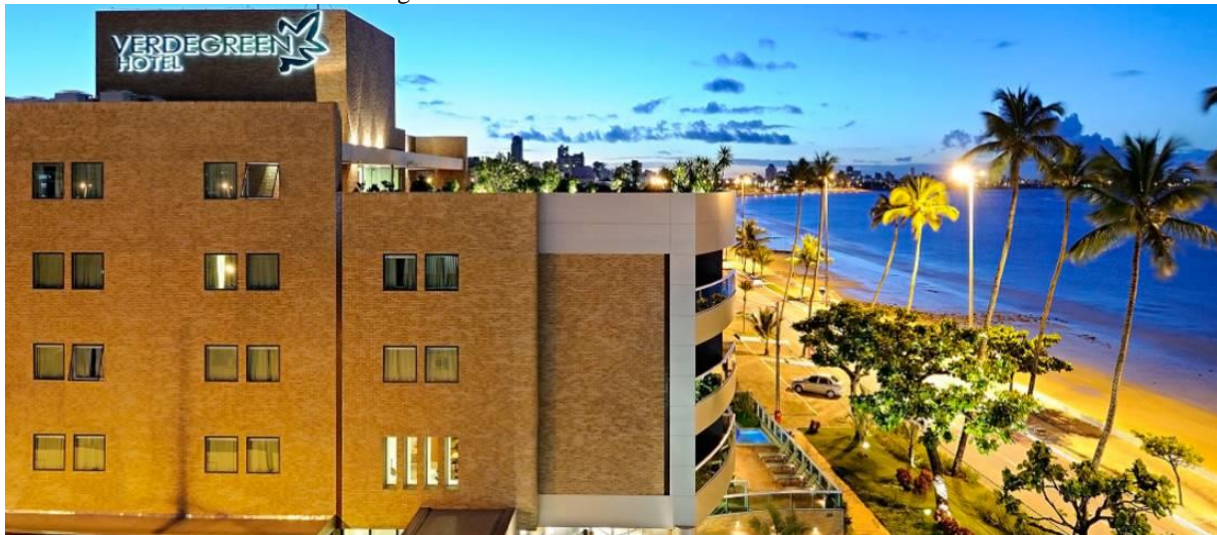
FIGURA 58 – Fachada Hotel Verdegreen.
