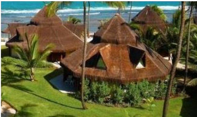
FIGURA 13 – Cobertura de palha piaçava
