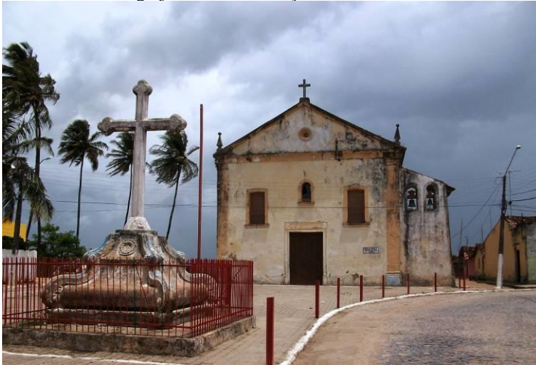
FIGURA 103 – Igreja de São Lourenço.
