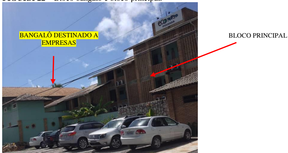
FIGURA 22 – Bloco bangalô e bloco principal.
