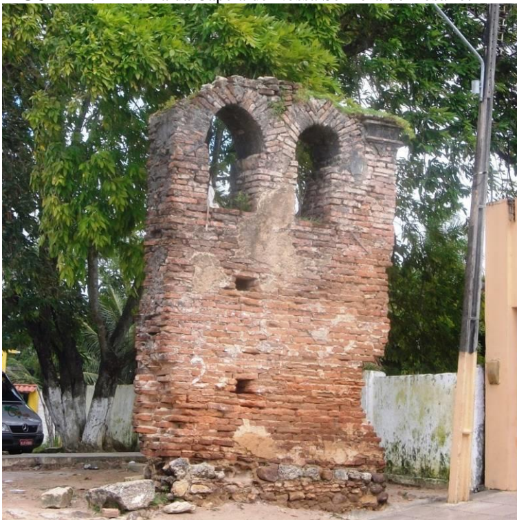
FIGURA 104 – Ruína da Capela de Nossa Senhora do Rosário.
