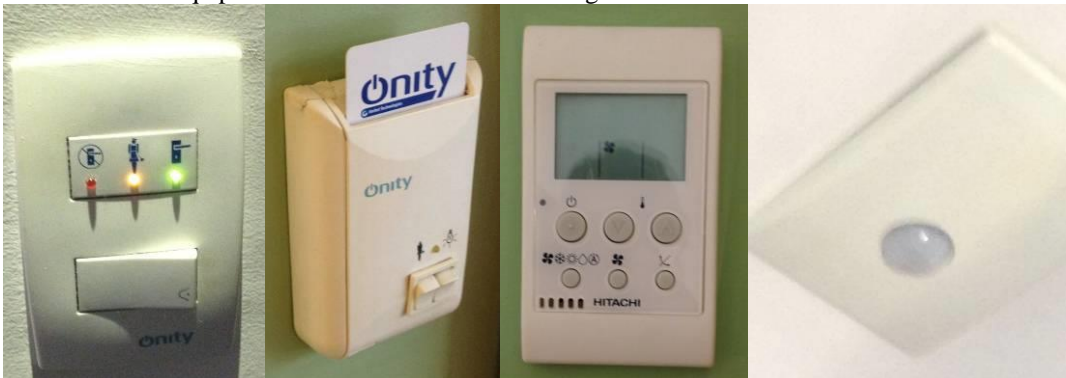
FIGURA 90 – Equipamentos economizadores de energia.
