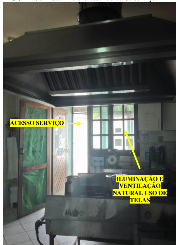
FIGURA 30 – Cozinha e acesso a área de serviço.
