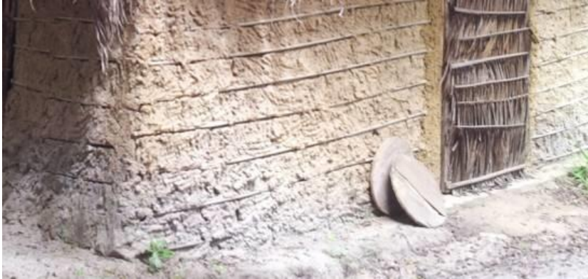
FIGURA 55 – Uso de barro e madeira em construção de taipa.
