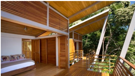
FIGURA 18 – Beiral de sombramento
