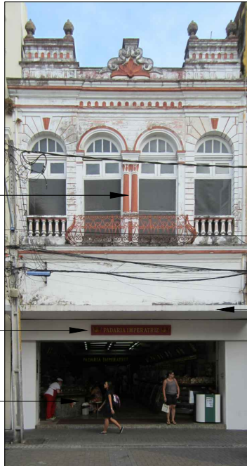
ESTADO ATUAL DA FACHADA DA EDIFICAÇÃO N° 240
