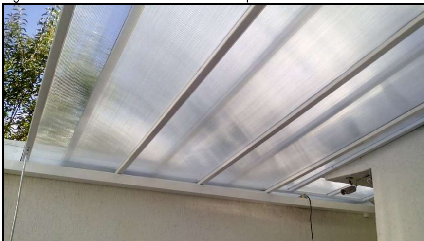
Figura 48 - Coberta em material semitransparente
