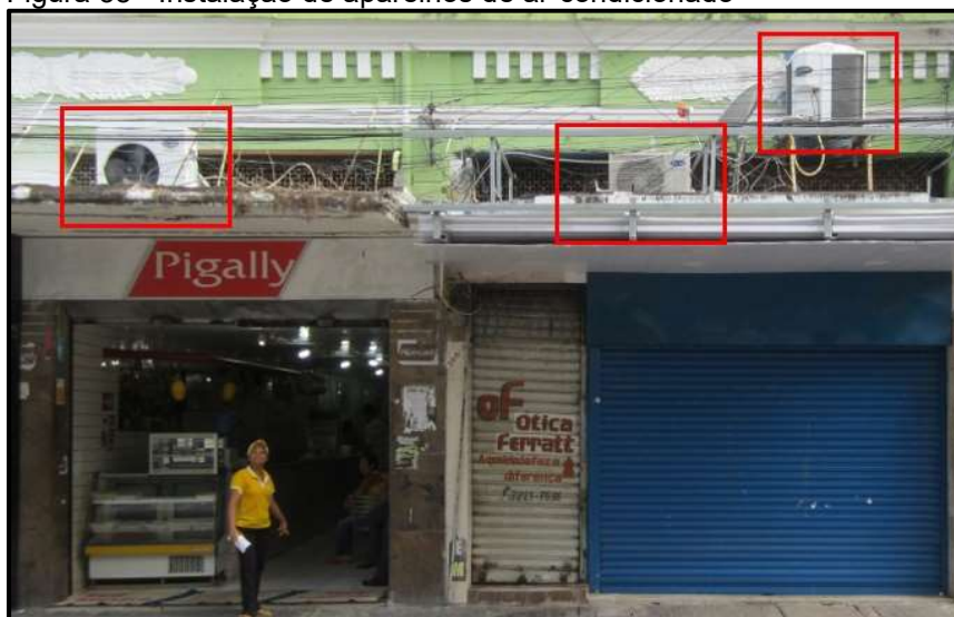
Figura 38 - Instalação de aparelhos de ar-condicionado
