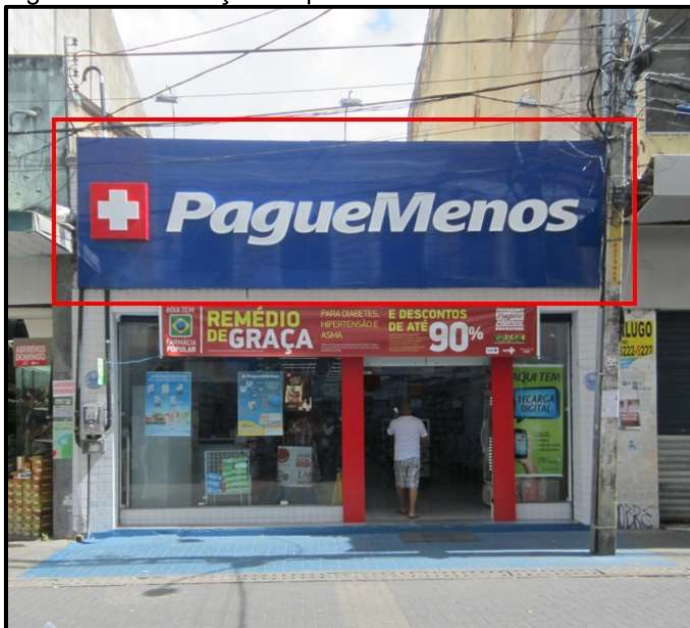
Figura 35 - Instalação de placa
