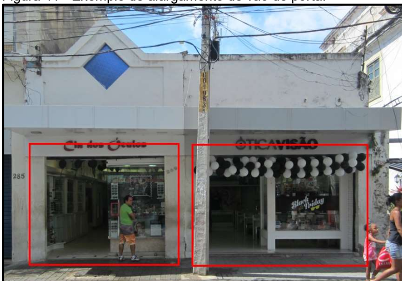
Figura 41 - Exemplo de alargamento de vão de porta.
