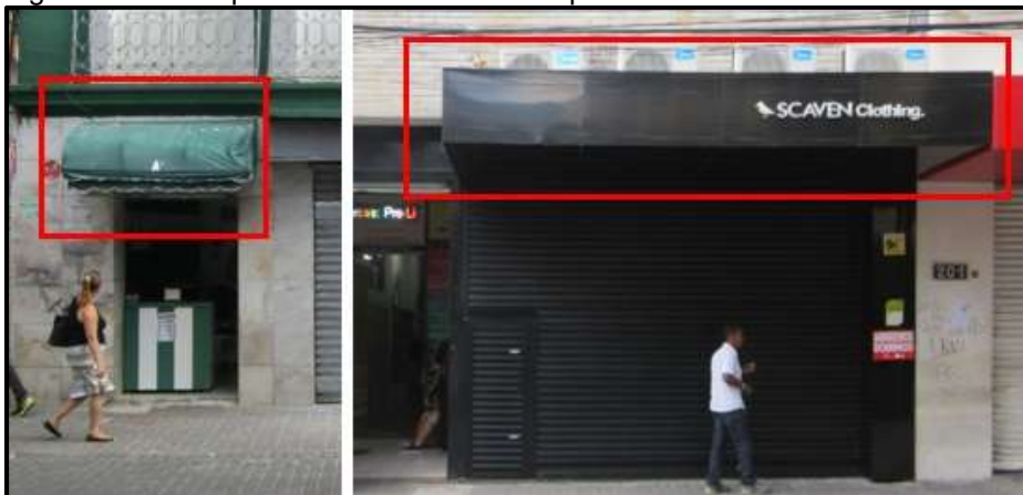
Figura 36 - Exemplos de toldo e cobertura improvisada
