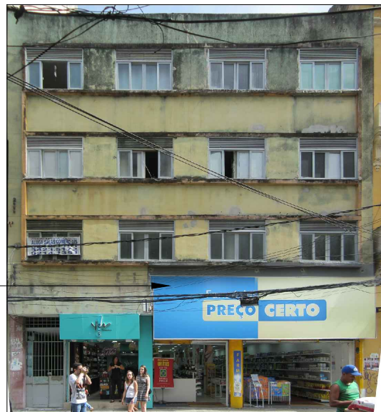
ESTADO ATUAL DA FACHADA DA EDIFICAÇÃO N° 134
