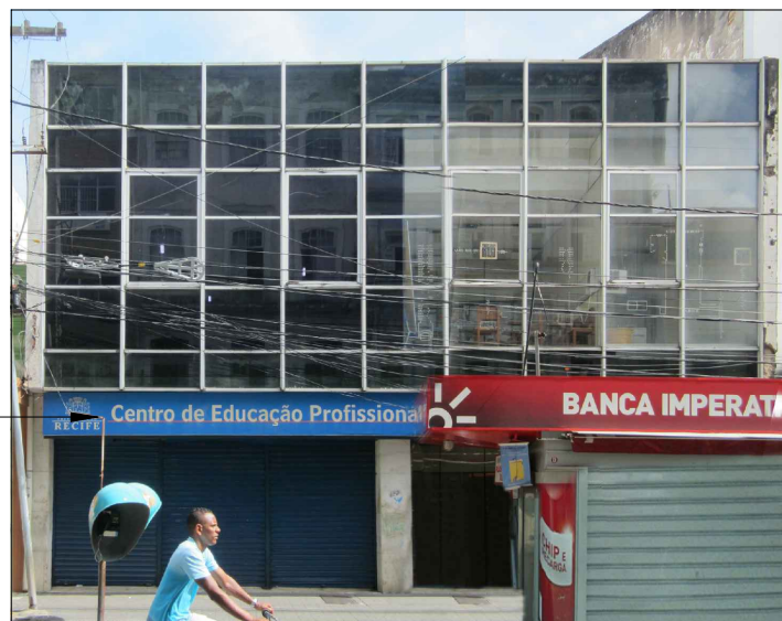
ESTADO ATUAL DA FACHADA DA EDIFICAÇÃO N° 182
