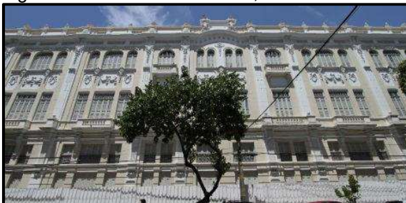
Figura 31 - Edifício Chantecler, Bairro do Recife.
