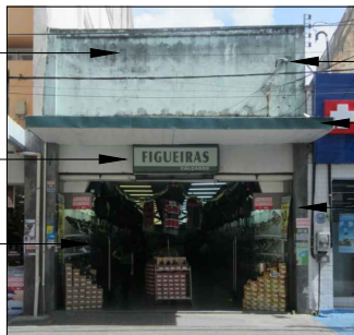
ESTADO ATUAL DA FACHADA DA EDIFICAÇÃO N° 94
