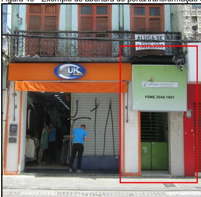
Figura 40 - Exemplo de abertura de porta/transformação de janela em porta
