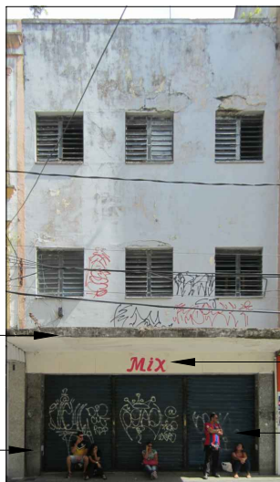
ESTADO ATUAL DA FACHADA DA EDIFICAÇÃO N° 42
