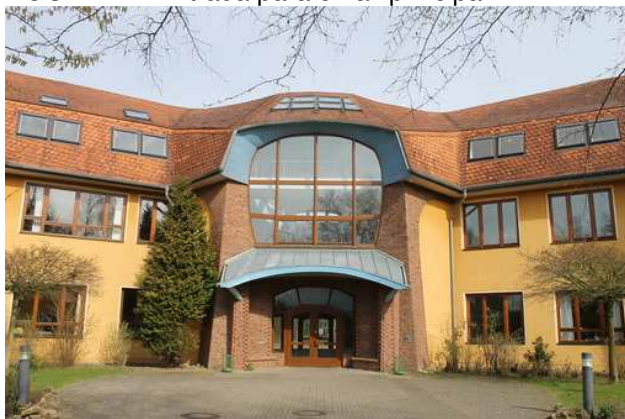
FIGURA 72: Entrada para o hall principal.
