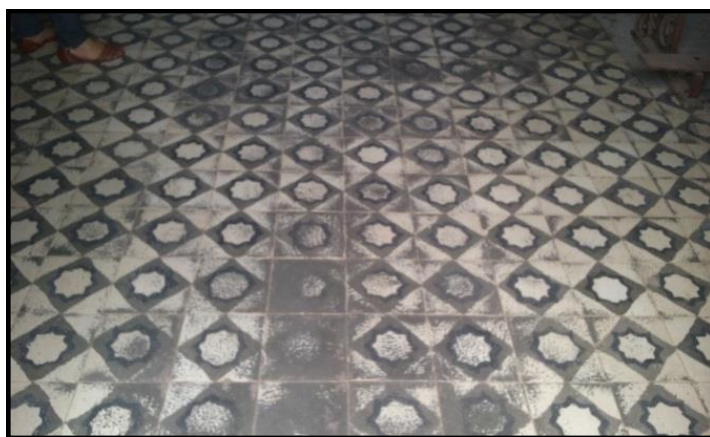
Figura 87: Piso da Nave Lateral.
