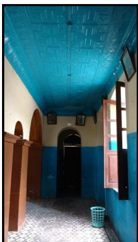
Figura 73: Forro da Nave Lateral.
