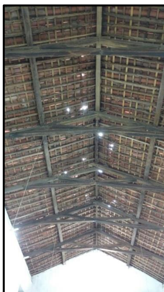
Figura 7: Estrutura do telhado
