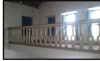
Figura 64: Guarda-corpo do Coro.
