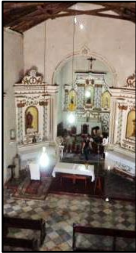
Figura 8: Piso da Nave Central.
