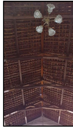
Figura 91: Estrutura do telhado.
