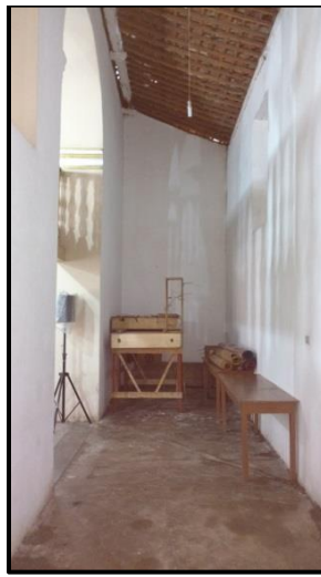
Figura 9: Piso da Nave lateral
