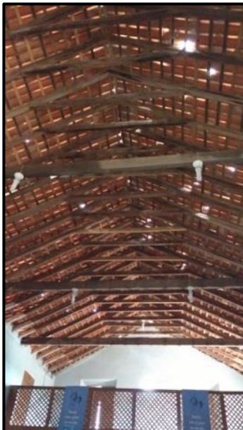
Figura 102: Estrutura do telhado.
