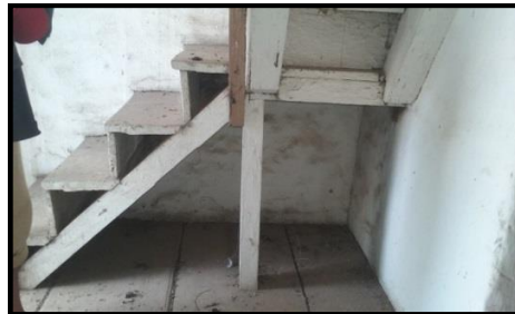
Figura 69: Escada de acesso ao 2º pavimento Torre Sineira.
