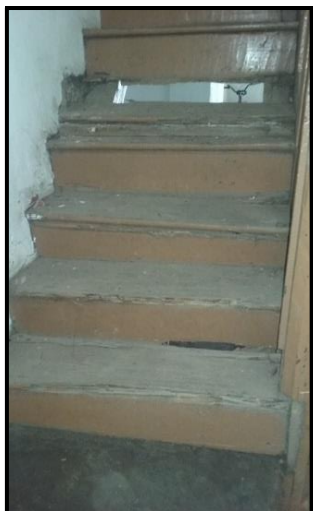
Figura 58: Escada de acesso a Galeria
