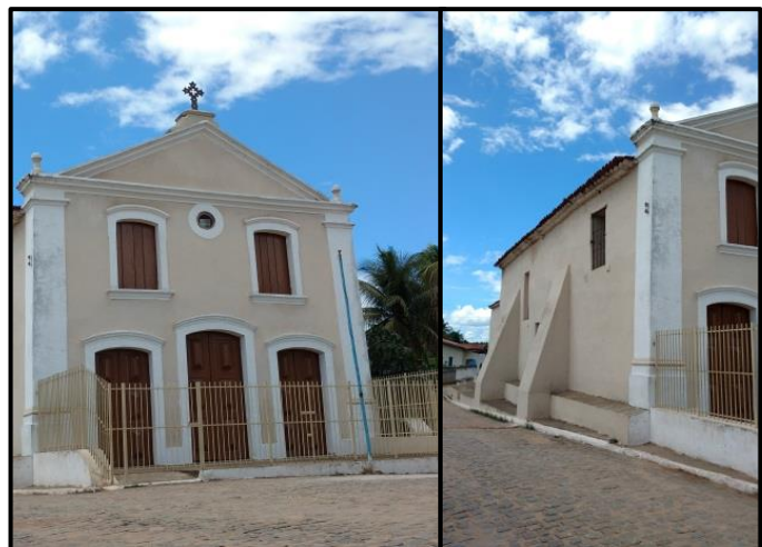
Figura 103: Gradil e Contrafortes.
