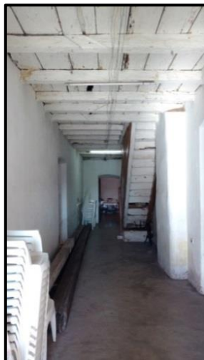
Figura 59: Vista interior do piso Galeria.
