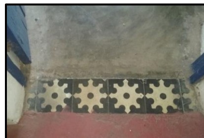
Figura 47: Detalhe Nave Central
