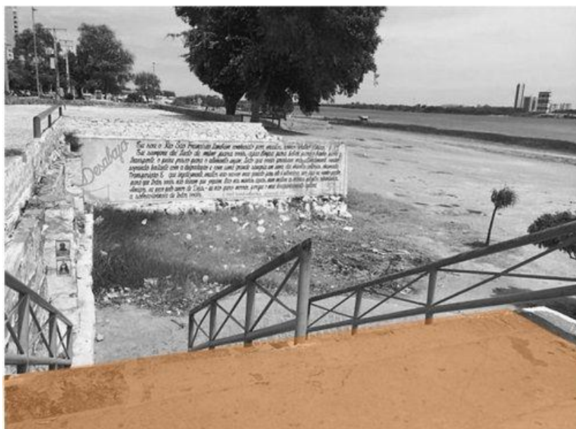
Figura 24 - Escada de acesso a travessia
