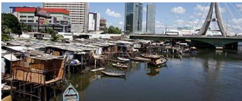
Figura 15 - Palafitas invadem o rio em Recife
