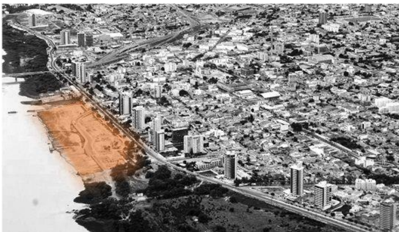
Figura 20 - Vista aérea da área denominada "Porta do Rio"
