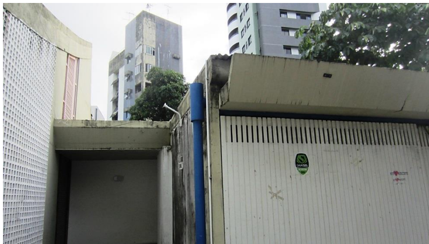
Acesso à edificação e bloco da garagem com a calha em concreto
