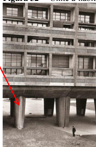
Figura 32 - “Unité d’habitation” Marseille
