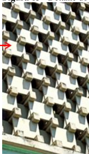
Figura 63 - Detalhe do cobogó
