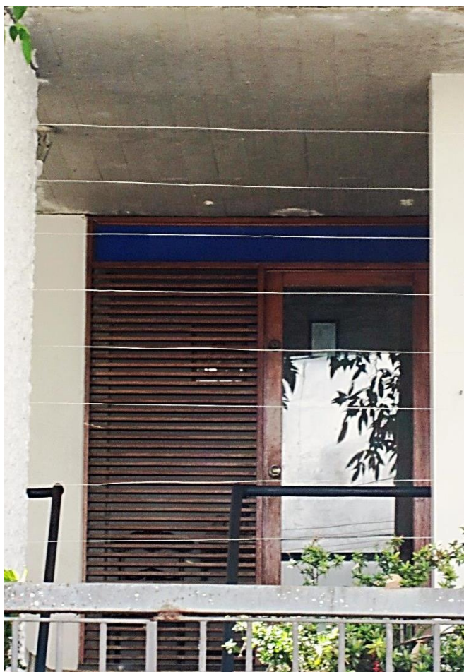
Detalhe da esquadria da porta – madeira com veneziana
