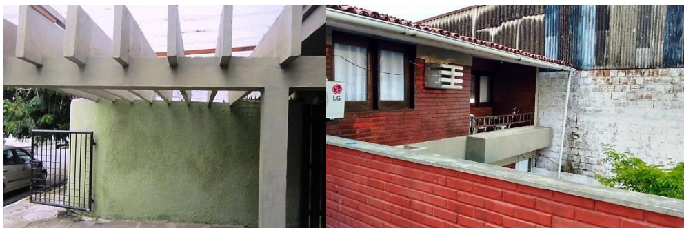
Pérgolas da fachada – proteção do veículo
