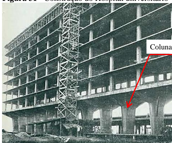
Figura 31 - Construção do Hospital universitário
