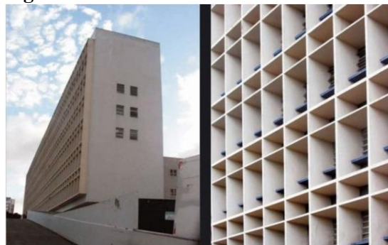
Figura 46 - Detalhe do “brise-soleil”
