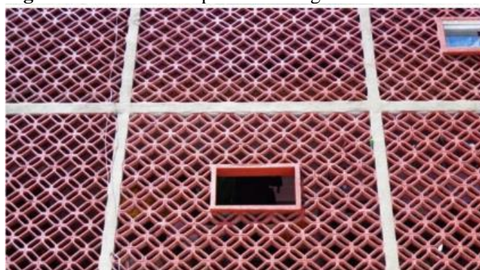
Figura 42 - Detalhe do pano de cobogós da fachada
