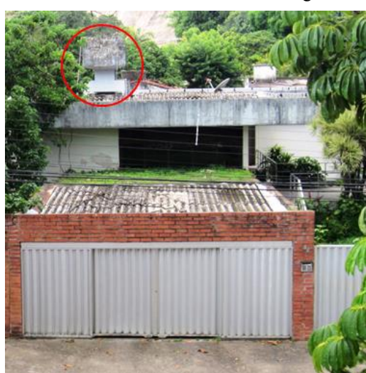
Fachada Frontal – detalhe da caixa d'água
