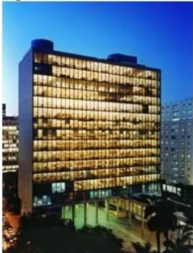
Figura 10 - MES - Fachada Norte
