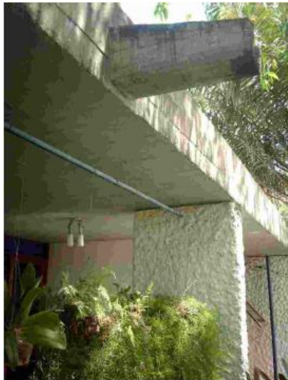
Detalhe da 'Gárgula de escoamento' em concreto (CANTALICE II, 2009)
