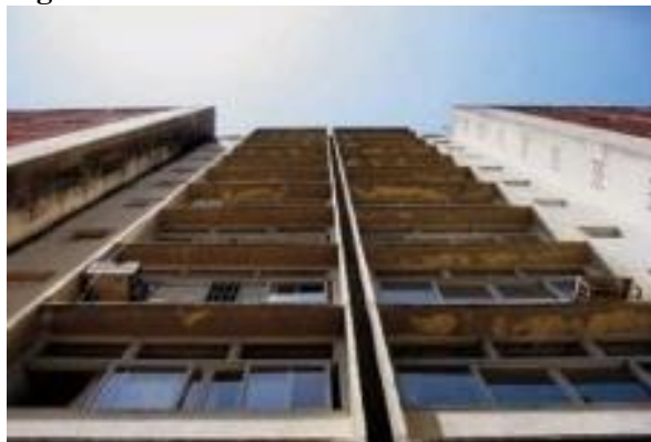
Figura 40 - Detalhe dos caixilhos em concreto
