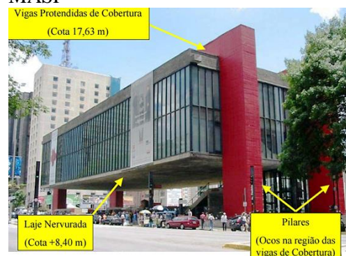
Figura 58 - Características Estruturais do MASP
