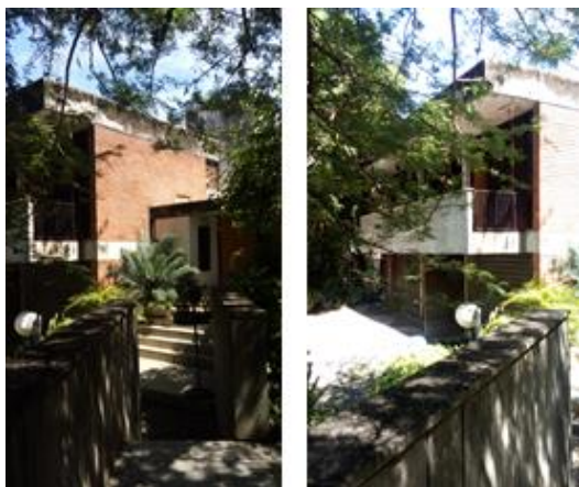
Detalhes da Fachada
