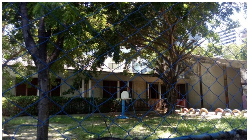
Fachada Frontal – vista do terraço de circulação, proteção solar aos ambientes
