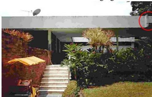
Fachada Frontal – detalhe da gárgula
