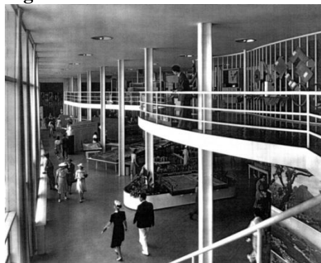
Figura 13 - Vista do “mezzanino”
