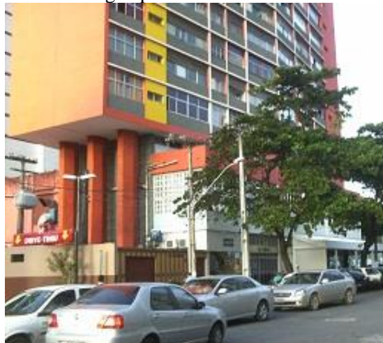
Figura 44 - Detalhe do volume vertical para descida de água pluvial
