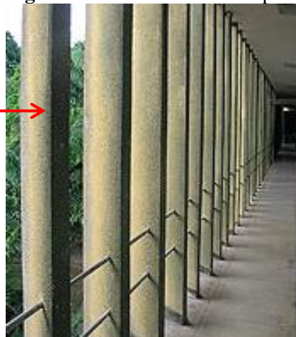
Figura 28 - Brises da fachada poente
