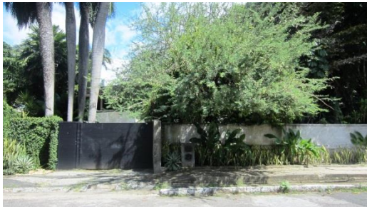
Vista da fachada – acessos
