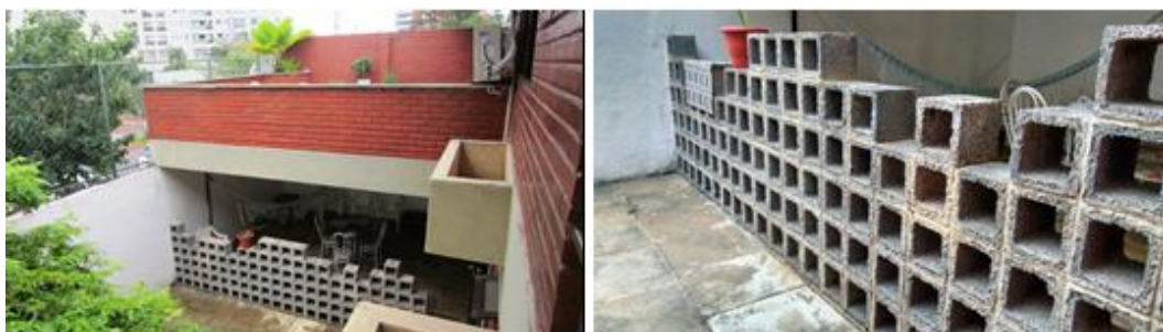
Vista do terraço pavimento térreo e do cobogó
