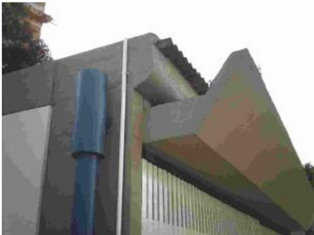
Detalhe da calha em concreto que saca da estrutura
