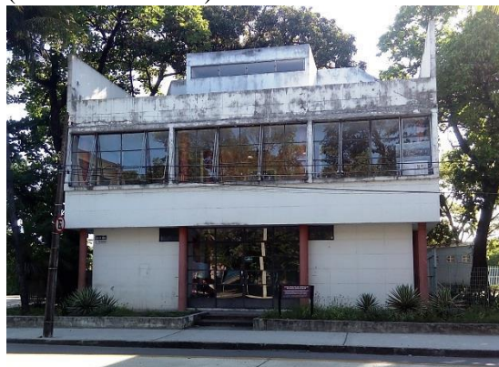
Figura 17 - Pavilhão de Verificação de Óbitos (Fachada em 2017)
