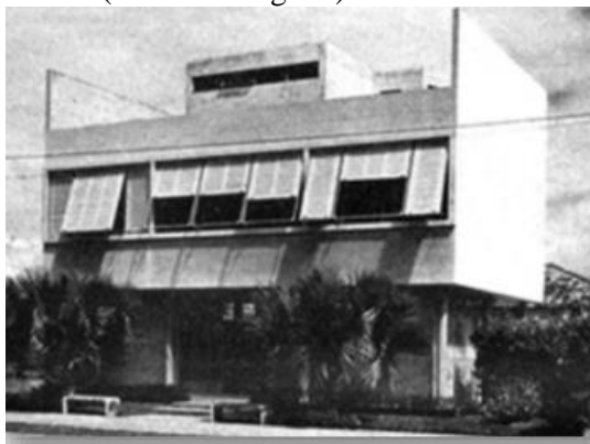
Figura 16 - Pavilhão de Verificação de Óbitos (Fachada Original)
