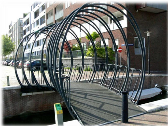
Figura 62 - Ponte de pedestre.
