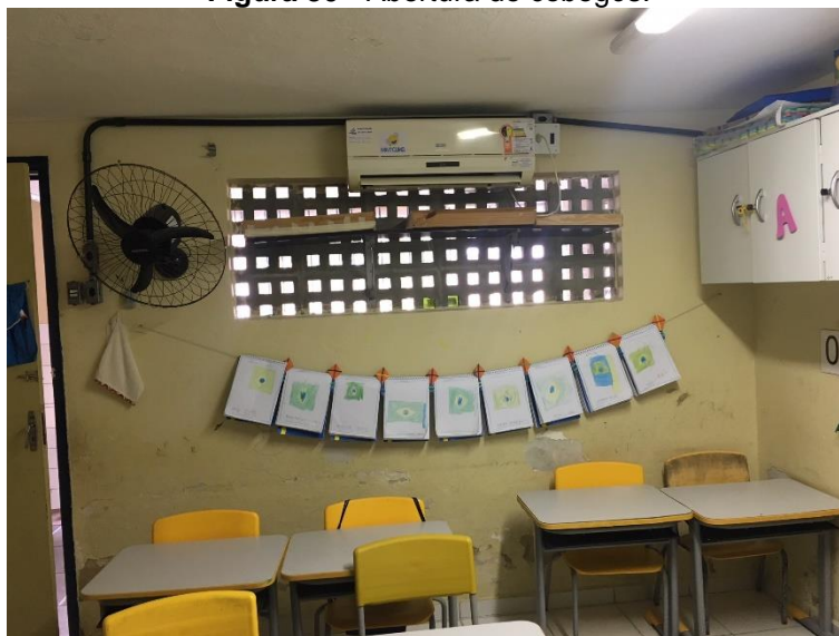
Figura 30 - Abertura de cobogós.
