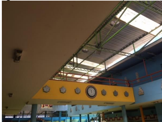
Figura 44 - Aberturas Zenitais do pátio interno
