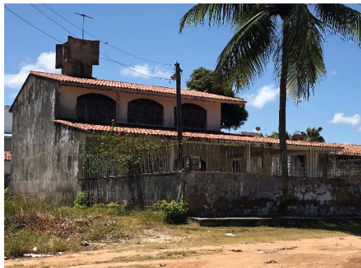
Figura 74 – Casa abandonada na Praia do Forte Orange
