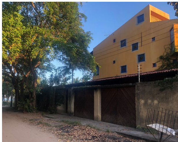
Figura 78 – Casa na Praia do Forte Orange.
