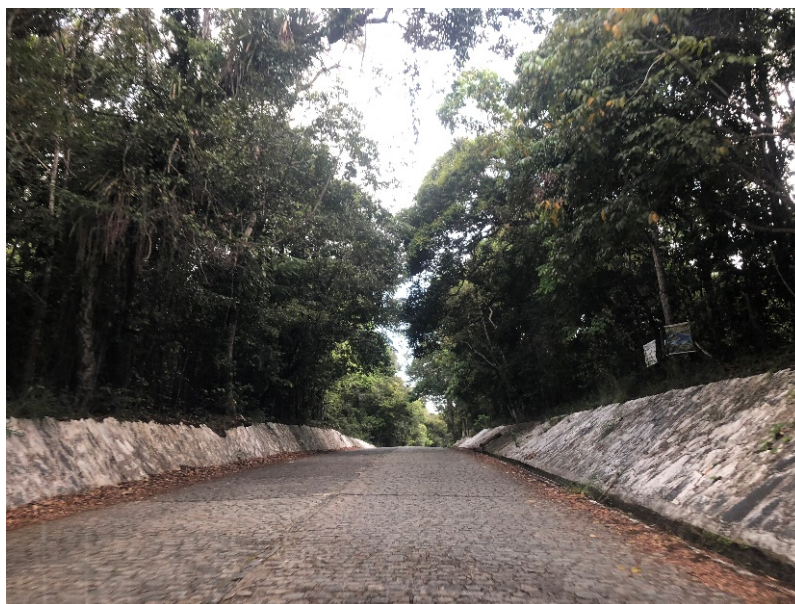
Figura 19 – Estrada de acesso à Vila Velha.
