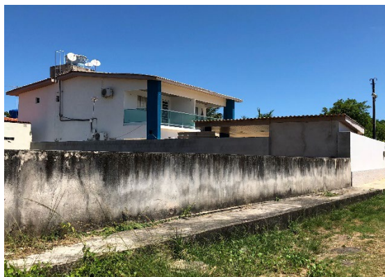
Figura 79 – Casa na Praia do Forte Orange
