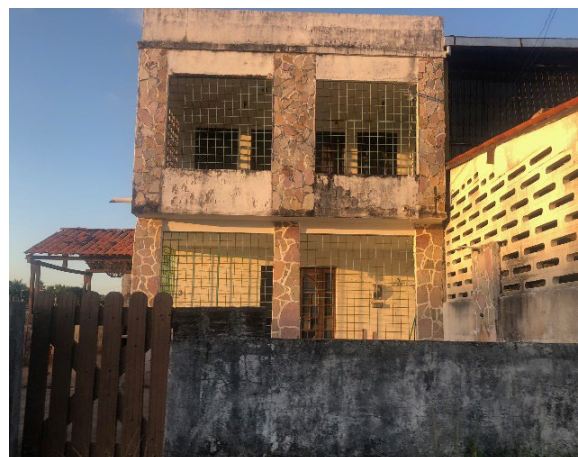
Figura 70 – Casa na Praia do Forte Orange
