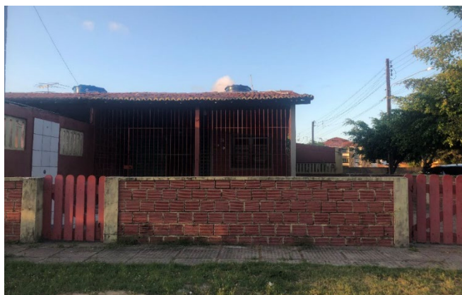
Figura 68 – Casa abandonada na Praia do Forte Orange.
