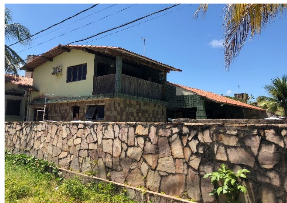
Figura 80 – Casa na Praia do Forte Orange
