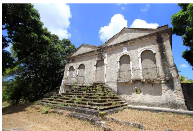
Figura 43 – Fachada da casa do abolicionista João Alfredo Corrêa de Oliveira.
