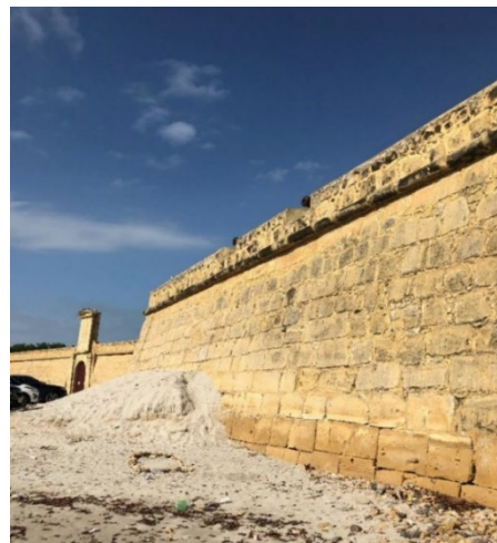
Figura 34 – Muralha na lateral do Forte
