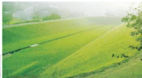
Bacia de infiltração
