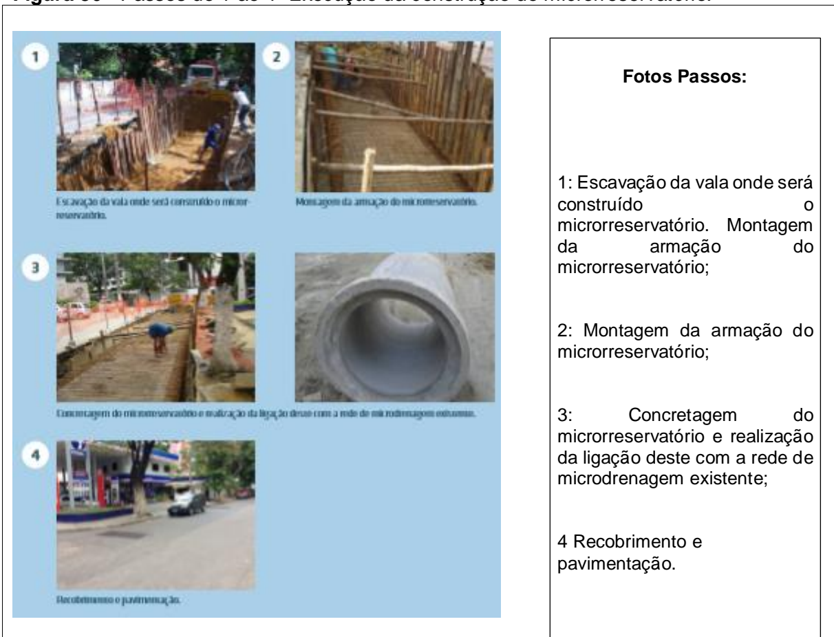
Figura 36 - Passos do 1 ao 4- Execução da construção do microrreservatório.
