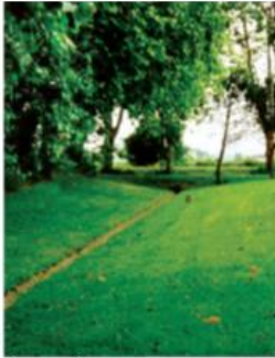
Valetas e planos para armazenamento e/ou infiltração
