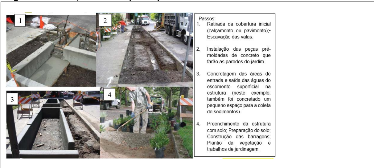
Figura 28 - Exemplo de execução de jardim de chuva
