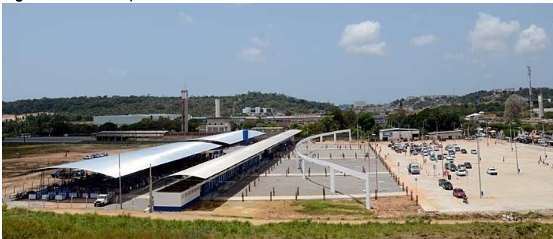
Figura 26 - Vista superior da nova estrutura da feira livre de Abreu e Lima.
