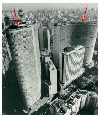
Figura 12: Edifícios Itália e Copan, respectivamente.
