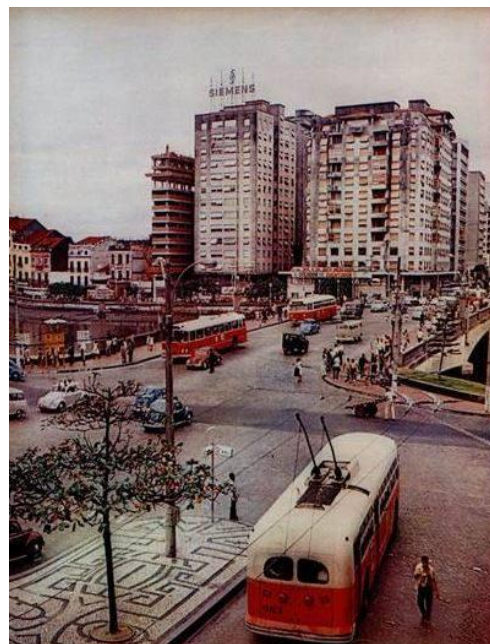
Figura 59: Edifícios Duarte Coelho, Santa Alice e o edf. Luziadas em construção, década de 1960.
