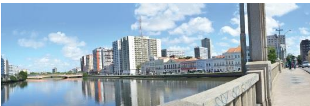
Figura 69: Vista da ponte Princesa Isabel para uma parcela da Rua da Aurora.
