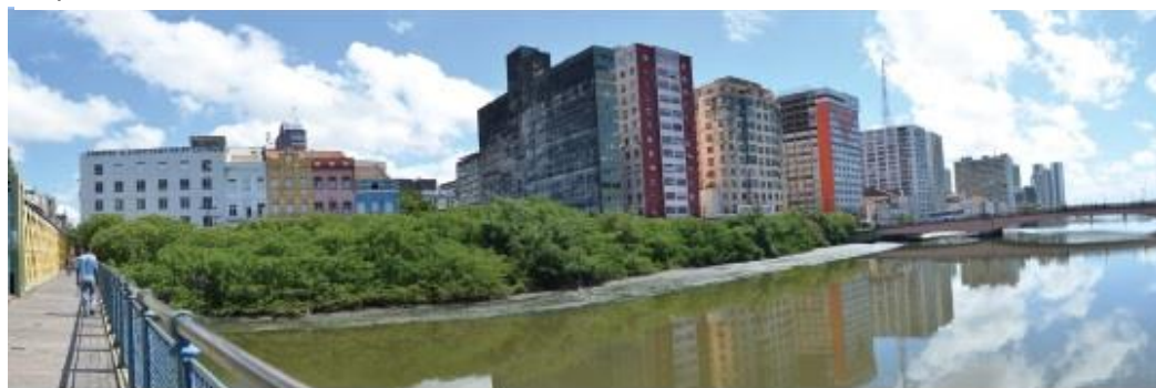
Figura 74: Vista VB1. a. e o corte esquemático com situação atual e simulação, respectivamente.
