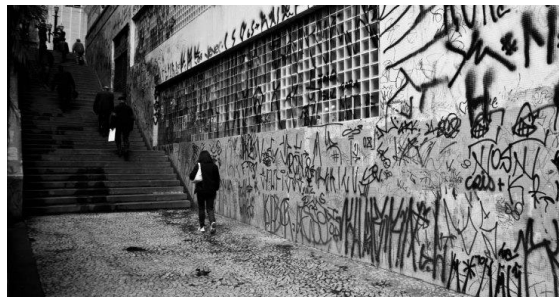
Figura 7: Muros com pichações, São Paulo.
