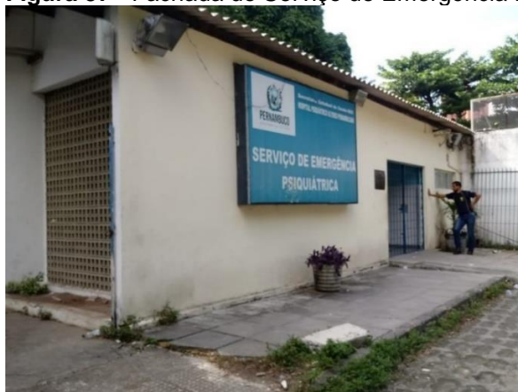
Figura 37 - Fachada do Serviço de Emergência Psiquiátrica do Hospital Ulysses.
