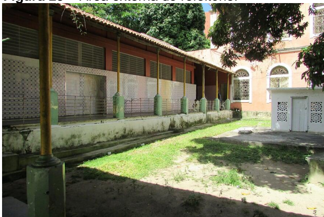
Figura 29 – Área externa do refeitório.
