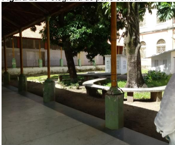
Figura 28 - Fotografia do pátio central.
