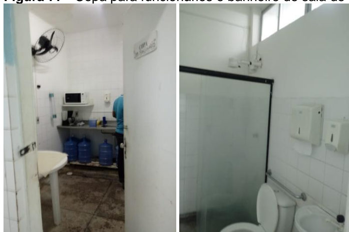
Figura 77 - Copa para funcionários e banheiro de sala de repouso de médicos.
