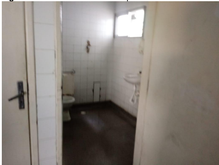
Figura 46 - Banheiro da sala de espera.
