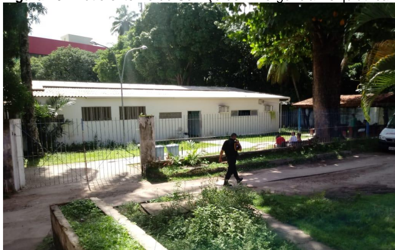
Figura 70 - Pátio externo do Serviço de Emergência Psiquiátrica
