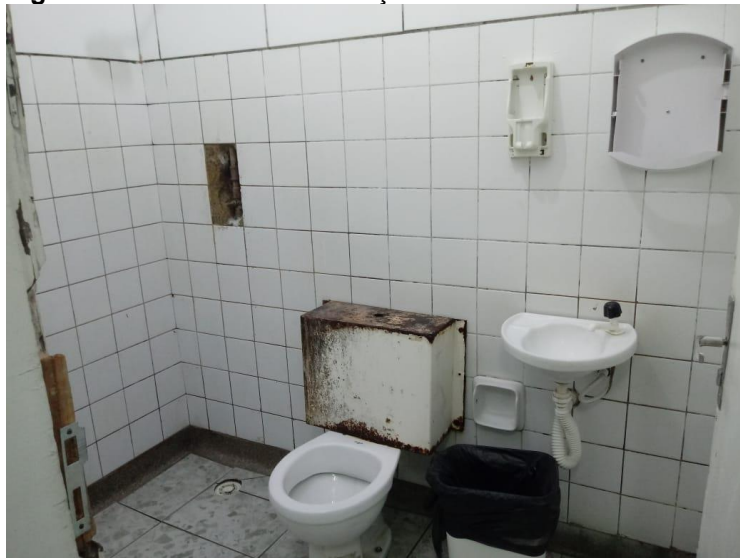
Figura 47 - Banheiro da circulação.
