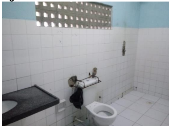
Figura 57 – Banheiro da enfermaria masculina
