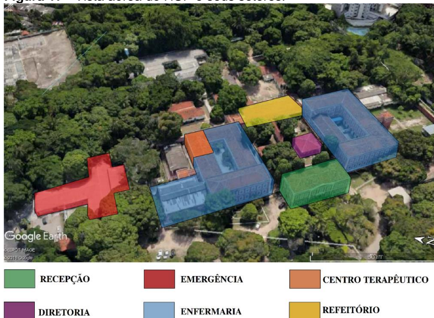
Figura 17 - Vista aérea do HUP e seus setores.
