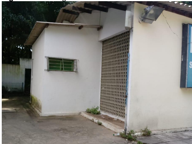
Figura 44 - Cobogós da sala de atendimento.
