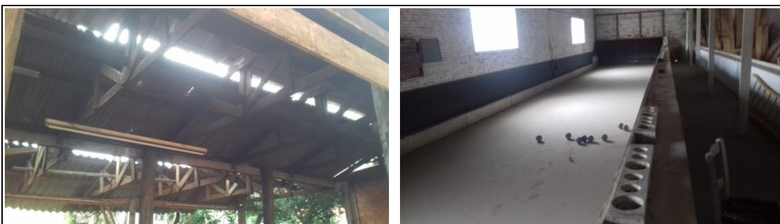
Foto 23. Telhado da Churrasqueira externa e a cancha de bocha
