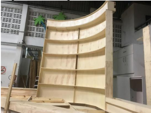
Figura 40 – Montagem Estande de vendas
