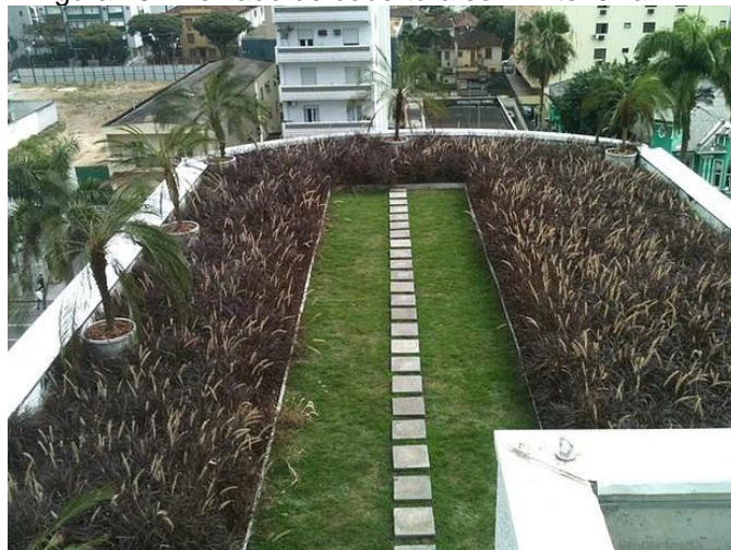
Figura 13 - Telhado de cobertura semi intensiva.
