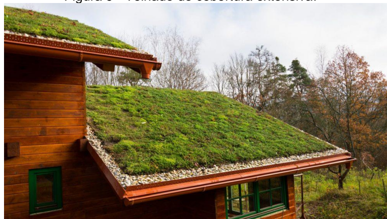
Figura 9 - Telhado de cobertura extensiva.
