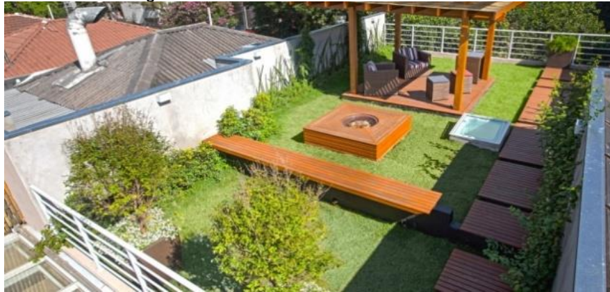
Figura 12 - Telhado de cobertura intensiva.
