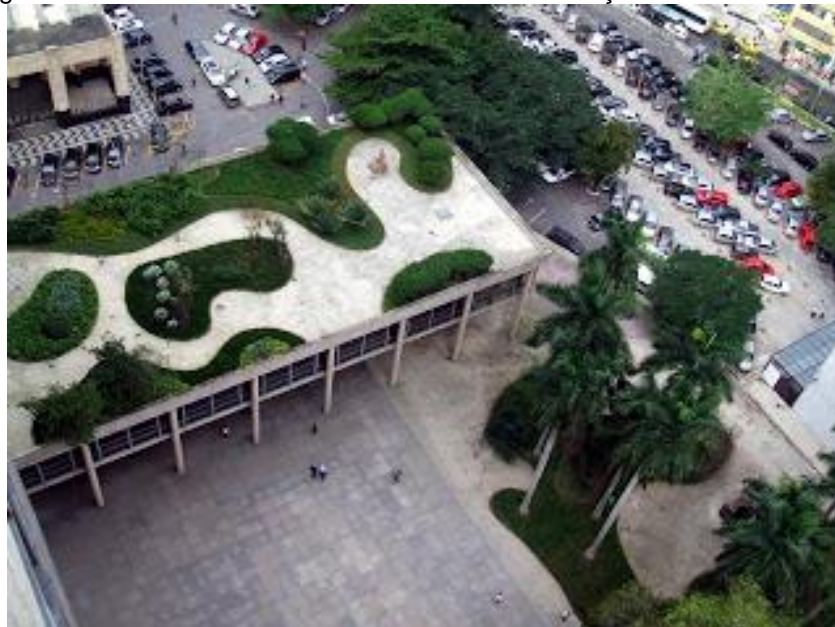
Figura 5 - Telhado do o Ministério da Saúde e Educação do Rio de Janeiro.
